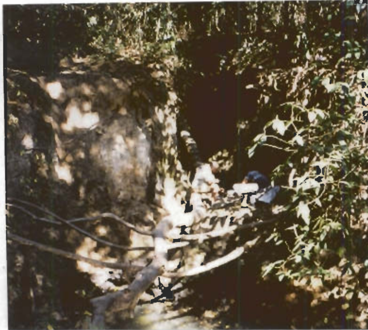
Figura 4.12 - Vista de trecho da voçoroca do Jardim Botânico.
