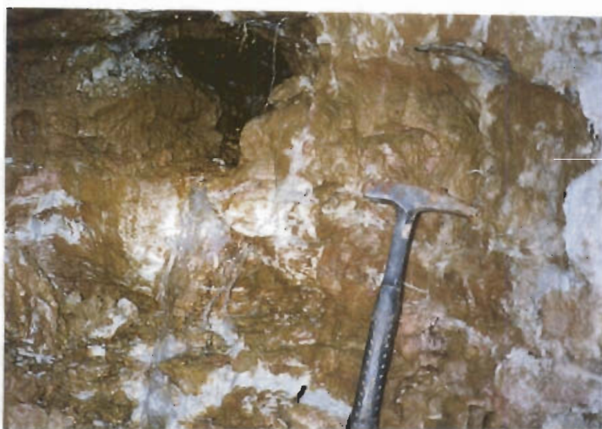
Figura 4.8 - Cavidade formada pelo processo de erosão interna ( piping )
