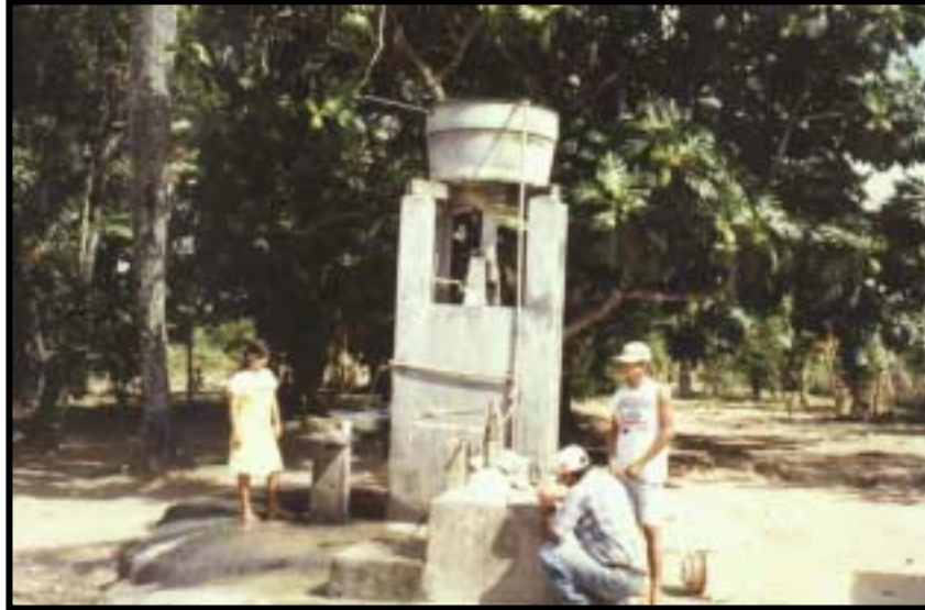
Foto 5 - Poço tubular pouco profundo captando água do aquífero livre do manto de intemperismo do fraturamento das rochas precambrianas. Engenho Genipapo.
