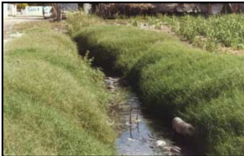
Foto 7 - Vala de recepção de águas domésticas na área urbana de Nossa Senhora do Ó, em área de ocorrência do terraço pleistocênico e dos sedimentos flúvio-lagunares.
