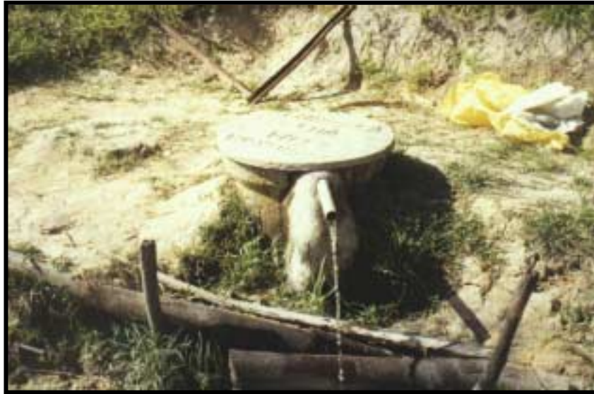
Foto 3 - Surgência (fonte) na encosta de um vale, no Aquífero Algodoads, com proteção de cimento, aproveitada para abastecimento. Engenho Canto.
