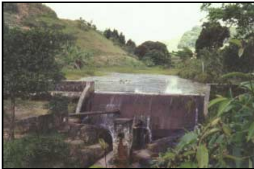
Foto 4 - Barragem para abastecimento d' água na área das rochas precambrianas. Distrito de Camela.
