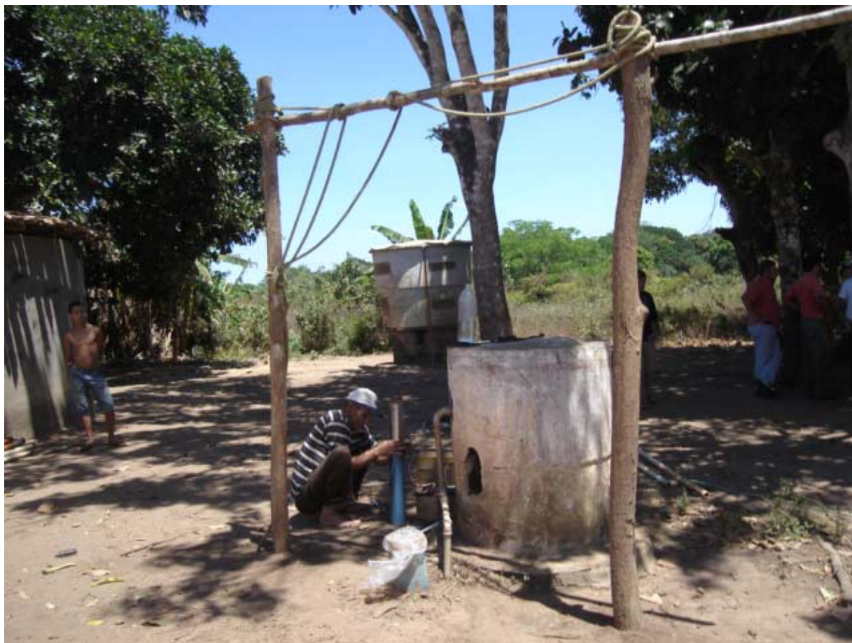
Foto 5.11 - Diagnóstico técnico do poço do Sítio Delgada
