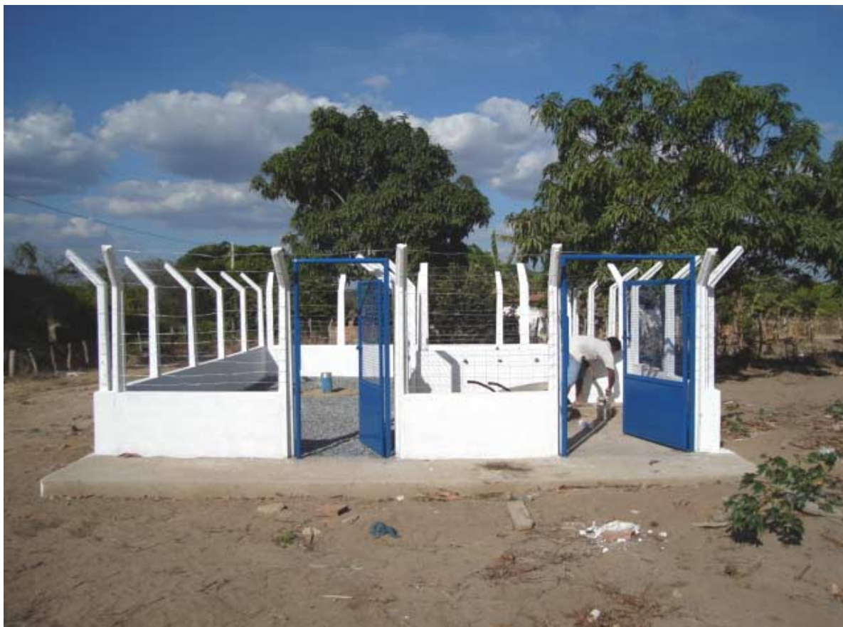
Foto 7.1 - Aspecto do SSA Sítio Delgada em fase de conclusão
