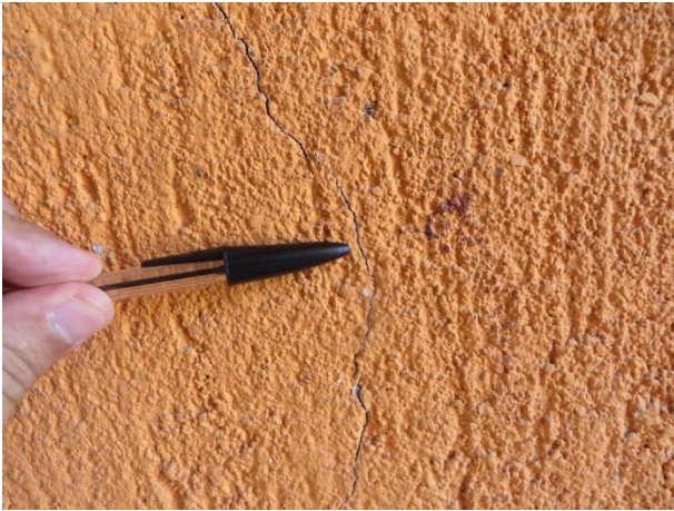
Figura 9. Fissura recente na parede de uma casa situada à Rua Monte Alegre.
