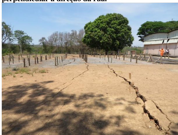
Figura 4. Grupo de pelo menos três rachaduras no terreno, arqueadas, com mais de 10 cm de abertura em alguns pontos e persistência superior a 100 m. Notar arqueamento com centro de curvatura situado em direção à Rua Mato da Lagoa, à esquerda da foto.
