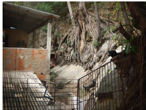
Figura 9. Imagem ampliada do talude na casa vizinha. Pode ser vista a rocha sã e a porção com solo e raízes, acima.
