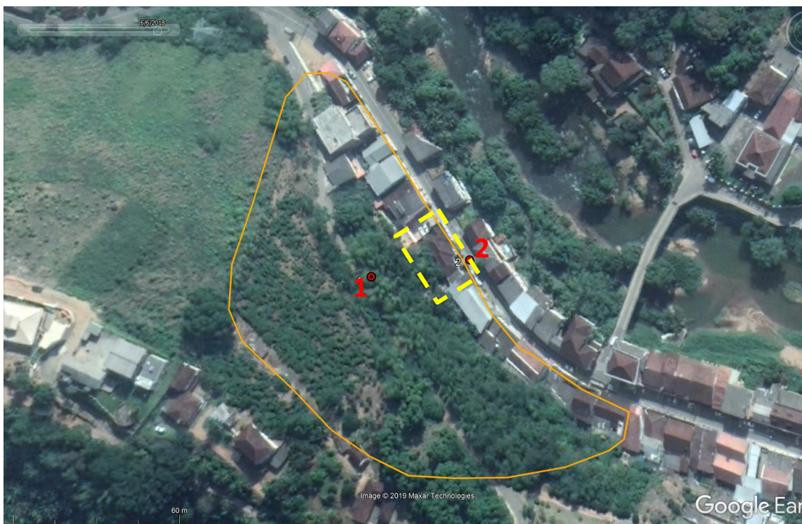
Figura 1. Setor de risco geológico ES_SL_SR_14_CPRM, em Santa Leopoldina - linha contínua laranja e destaque para o imóvel do TRE - linha tracejada amarela. (Imagem: Google Earth).
