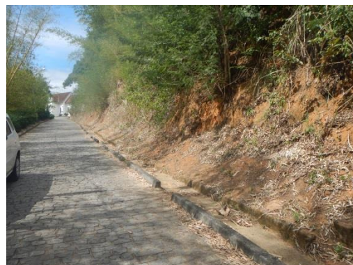
Figura 5. Drenagem e calçamento observados na Rua Padre Henrique Otto, vista em direção à Igreja.
