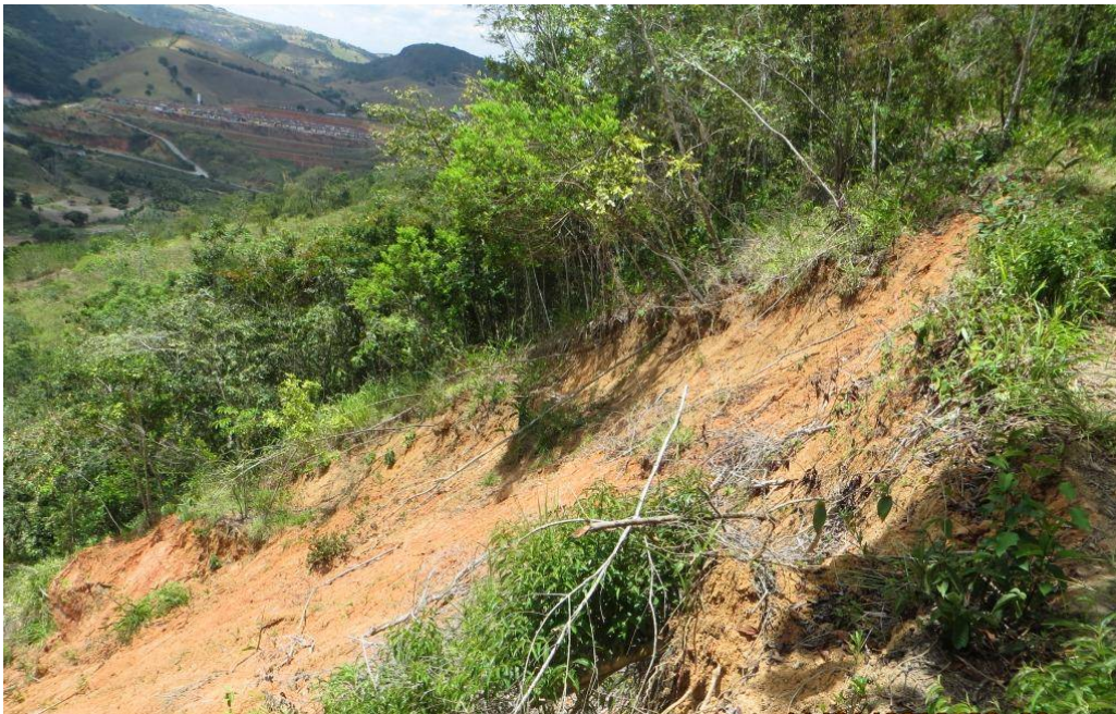
Figura 3 – Vista da crista do escorregamento.
