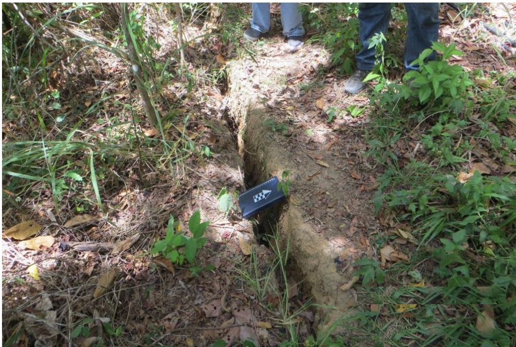
Figura 5 – Trinca de abatimento localizado na lateral da ruptura principal.
