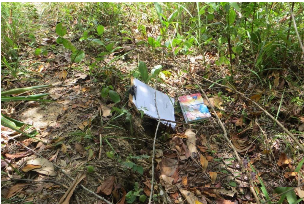
Figura 6 – Trinca de abatimento localizado na lateral da ruptura principal. Notar o degral formado.
