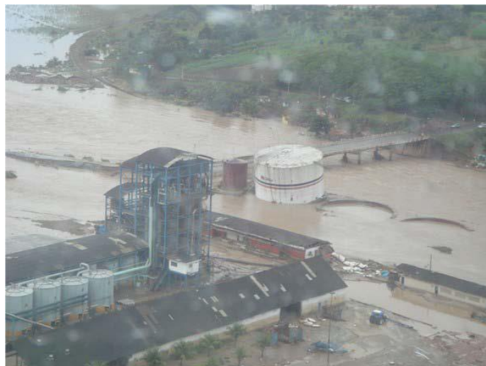
Figura 11 - Usina Laginha no município de União dos Palmares, durante a cheia de junho de 2010, no rio Mundaú. Destaque para o local onde funcionava o tanque de álcool. Fonte: CPRM, 2010.
