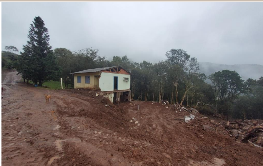
Figura 11 – Casa atingida pelo deslizamento, parcialmente destruída.
