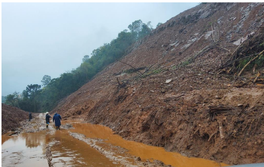
Figura 7 – Deslizamento na Linha São José.
