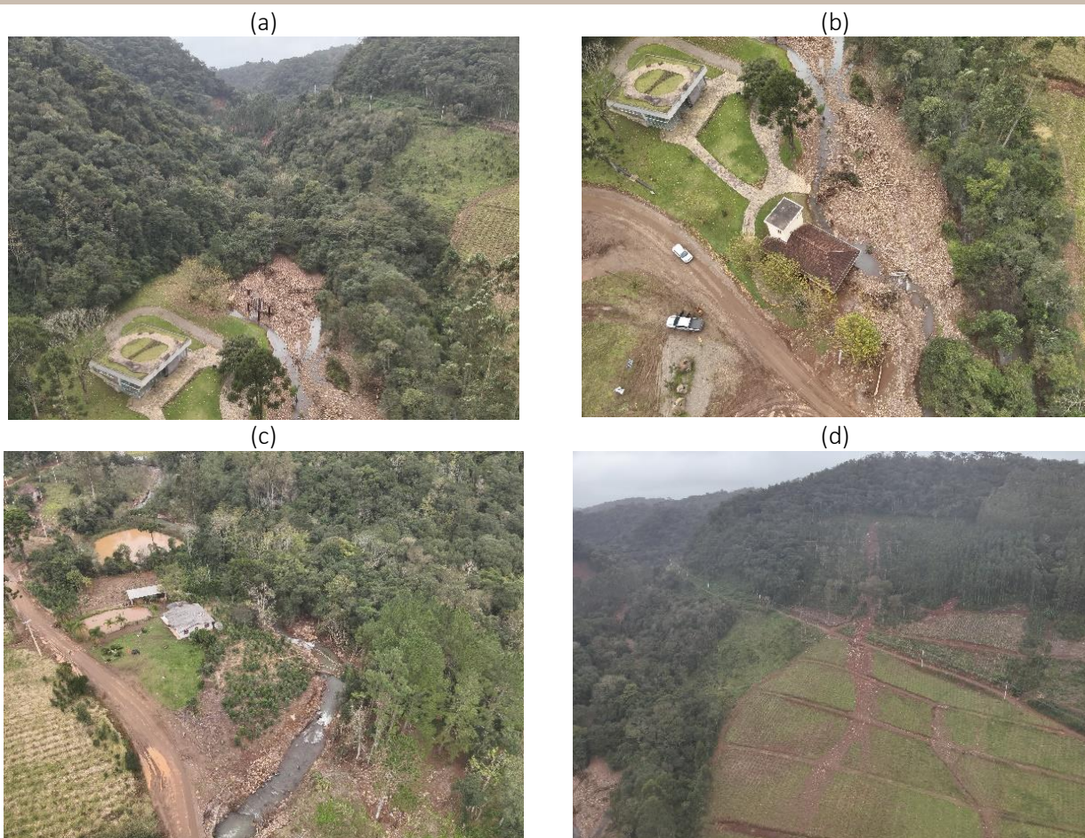
Figura 8 – Linha Carlos Barbosa -Usina de Putinga: (a) e (b) - Edificações a jusante de vale encaixado evidenciando material provindo de deslizamentos e grande fluxo de água; (c) – Vegetação arborea derrubada evidenciando enxurrada de alta energia e (d) – Deslizamento planar raso em encosta de medio e alto aclive causando danos em vias de acesso e atividade de plantio.
