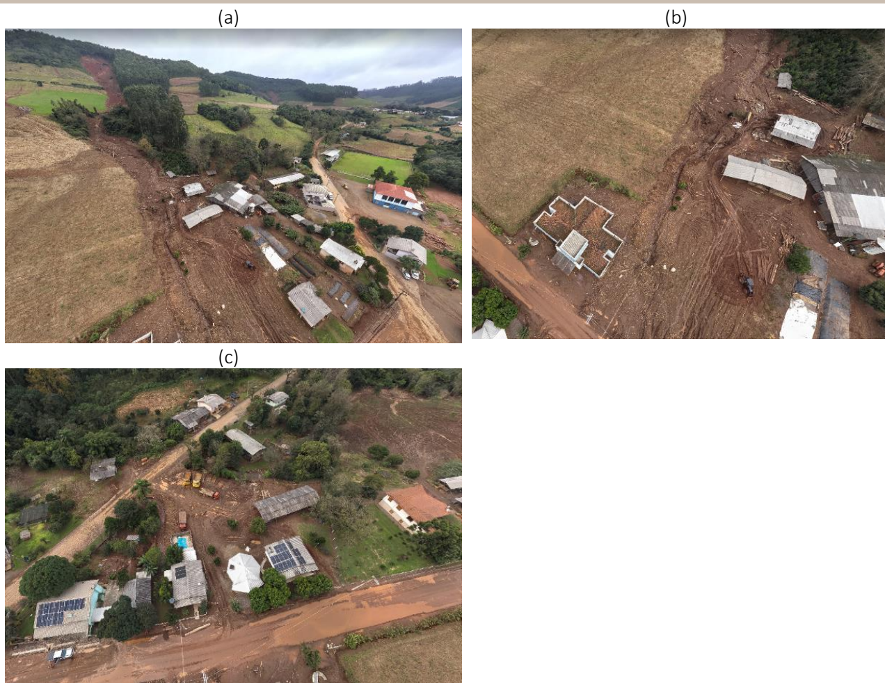
Figura 9 – Distrito de Charqueado: (a) – Deslizamento planar com movimentação de solo/lama em direção a edificações de alvenaria no sopé da encosta; (b) – Unidade de Saúde do município suscetível a danos por deslizamentos e (c) – Residências que sofreram danos pelo fluxo de lama e água.
