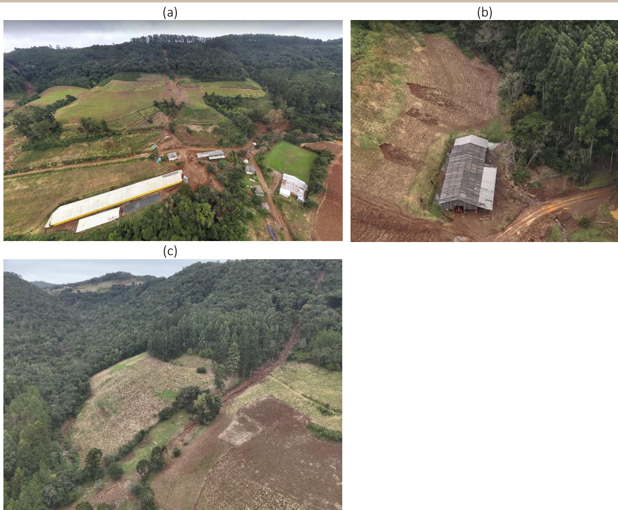
Figura 10 – Distrito de Três Barras: (a) – Deslizamento planar em vertente de alta declividade causando danos a edificações de alvenaria, (b) – Pequenos deslizamentos planares em encosta adjacente a edificação de madeira e (c) – Deslizamento planar com movimentação de solo e lama em plantação.
