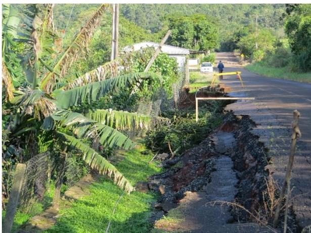
**Figura 10 –** Deslizamento rotacional, com degraus de abatimento, atingindo vias.
