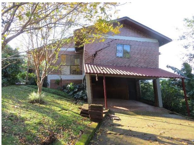
Figura 12 – Residência afetada pela movimentação do solo.
