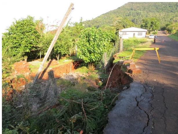
**Figura 11 –** Degráus de abatimento provocados pelo deslizamento rotacional em depósito coluvionar.
