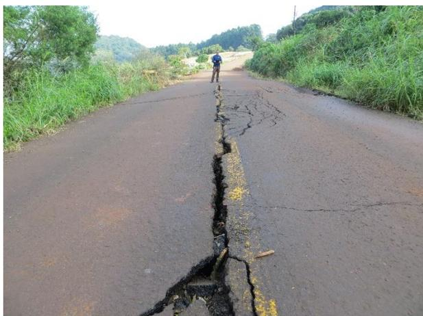
**Figura 4 – Via atingida por processo de rastejo de depósito coluvionar.**
