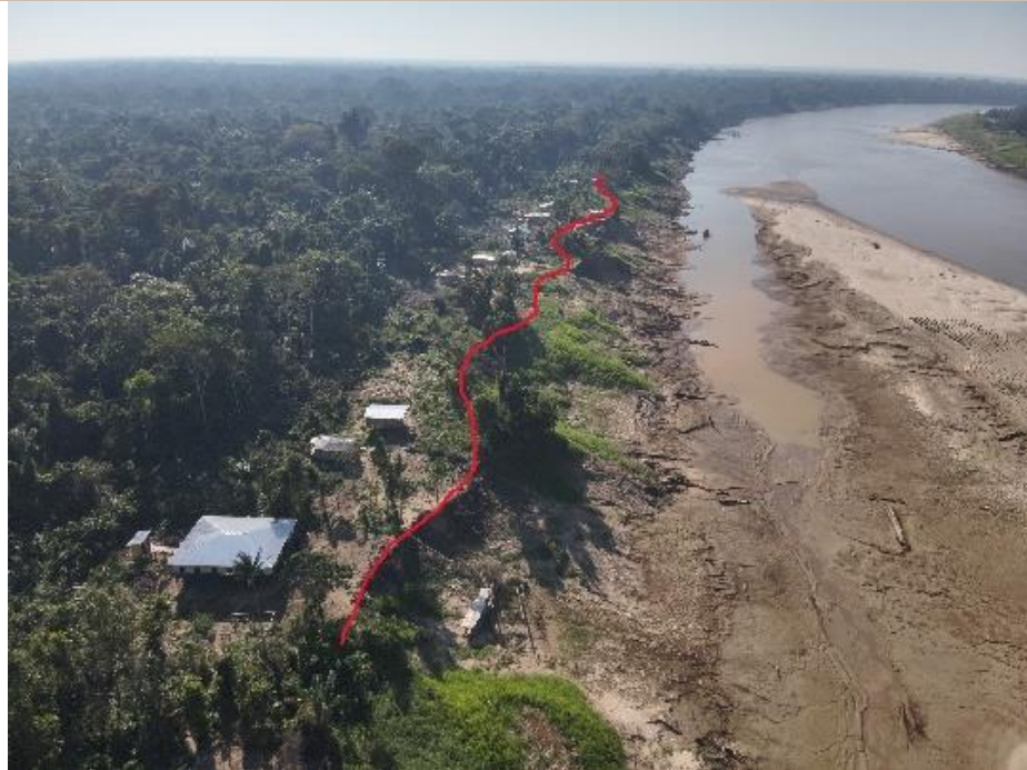
Figura 21: Imagem aérea obtida com o drone ressaltando a proximidade das moradias com a linha de erosão (em vermelho). Fonte: Autores.
