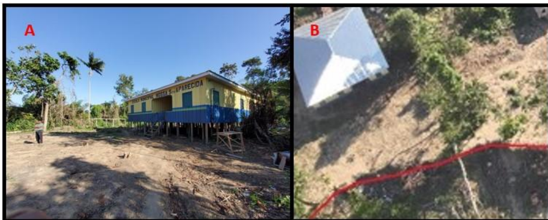
Figura 22: Foto aérea obtida com o drone destacando a proximidade da Escola Municipal Nossa Senhora Aparecida (A) com a linha de erosão (B). Fonte: Autores.
