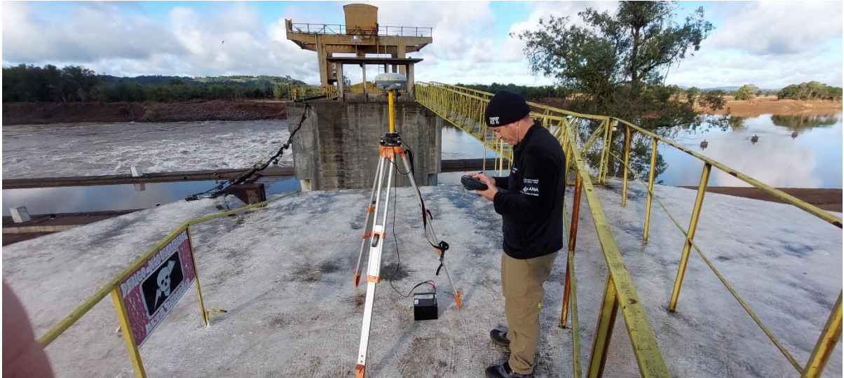
Figura 2. Levantamento com GPS-RTK na estrutura da eclusa de Bom Retiro do Sul.
