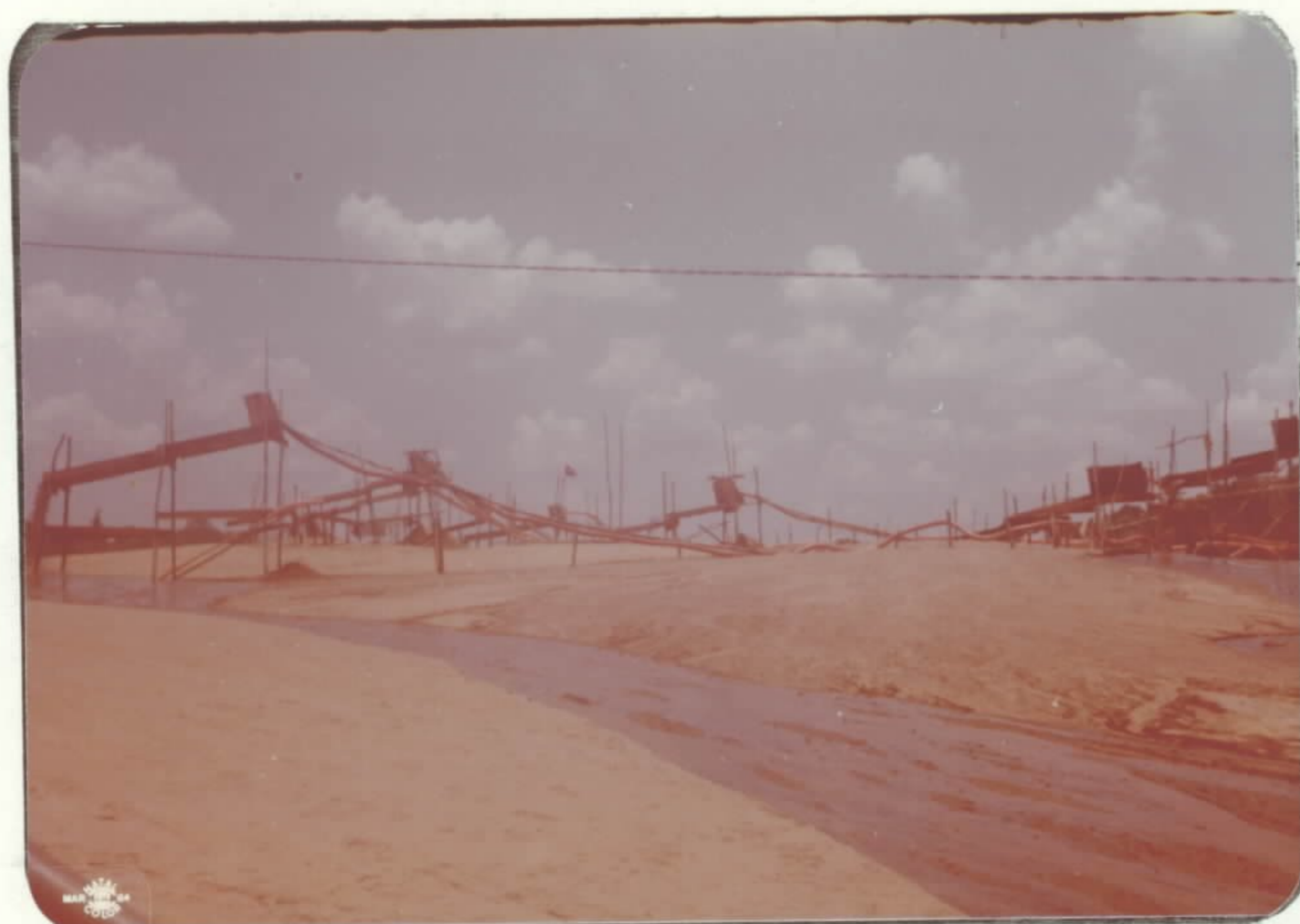
Foto nº 10 - Caixas para concentração de ouro, montadas em terra - setor Paredão.
