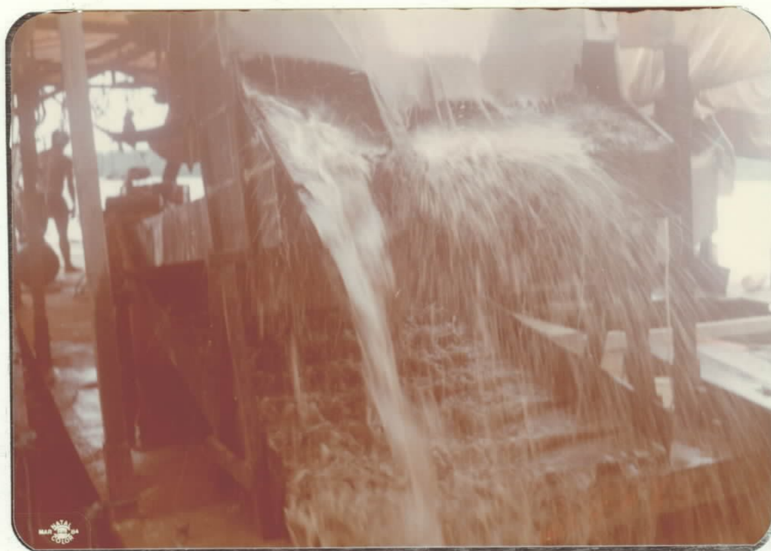
Foto nº 16 - Balsa operando com elevada perda de material sus- cicionado (alimentação).
