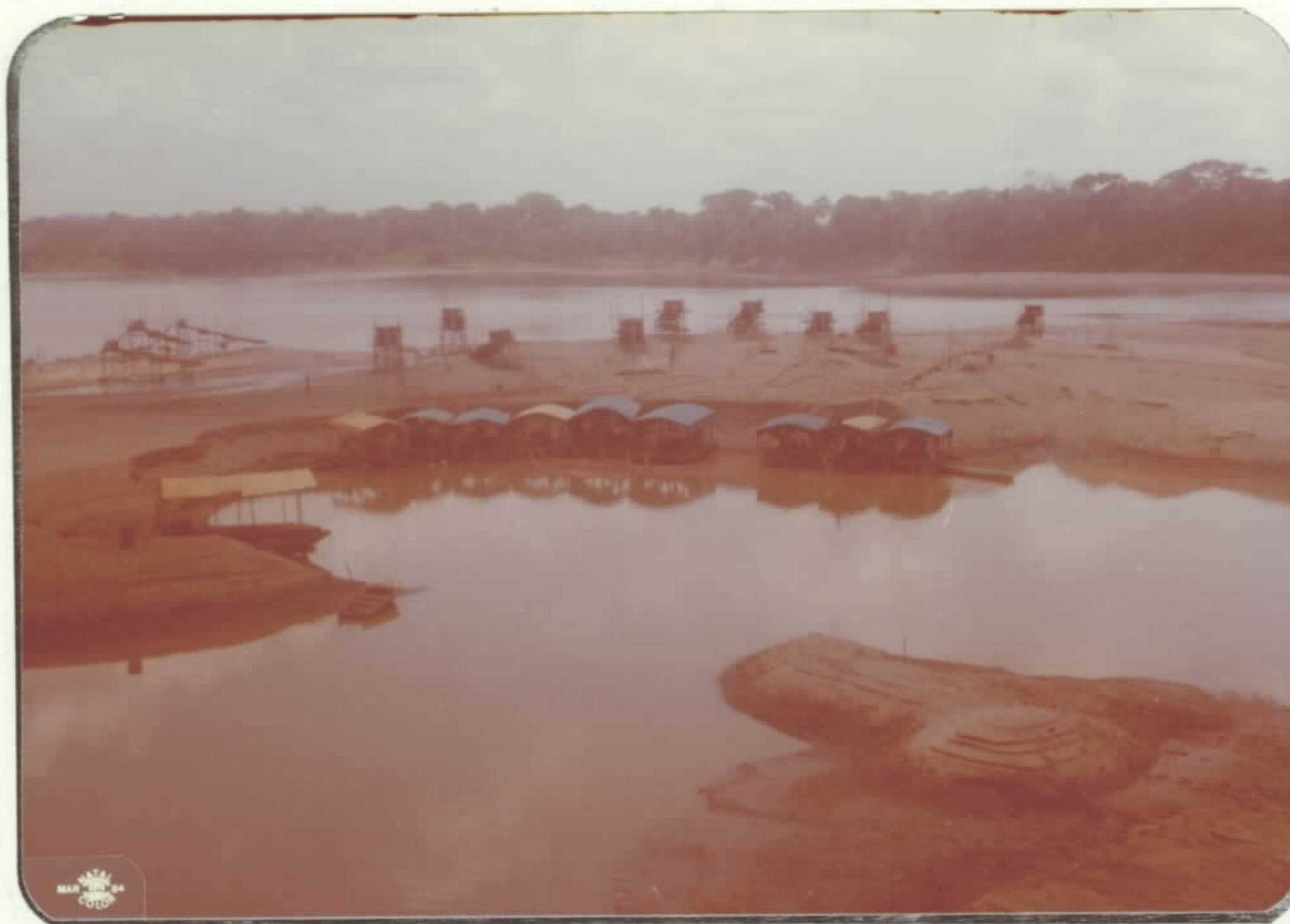
Foto nº 11 - Balsa operando em "lagoa", ao fundo vê-se as caixas de concentração para onde se dirige o material succionado do setor Paredão.
