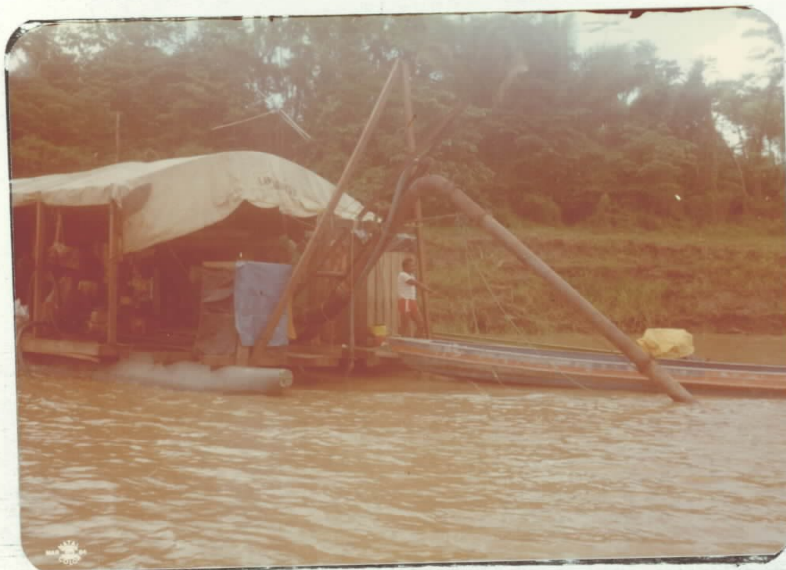
Foto nº 8 - Draga, observando-se o formato da tubulação de ferro que compõe a "lança" para perfurar o leito do rio.
