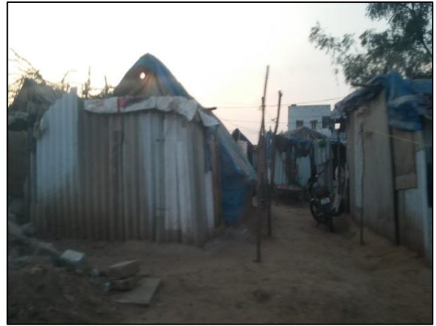
Figura 6 – Moradias precárias em rua próxima ao Instituto.
