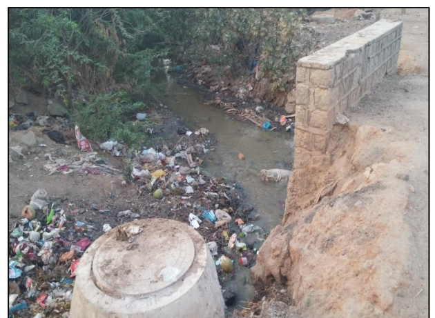
Figura 4 – Lixo e esgoto em rua próxima ao Instituto.
