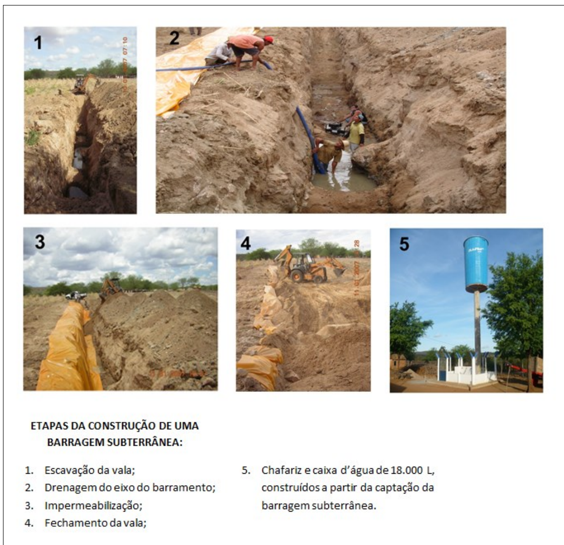
Figura 3: Etapas de construção de uma barragem subterrânea
