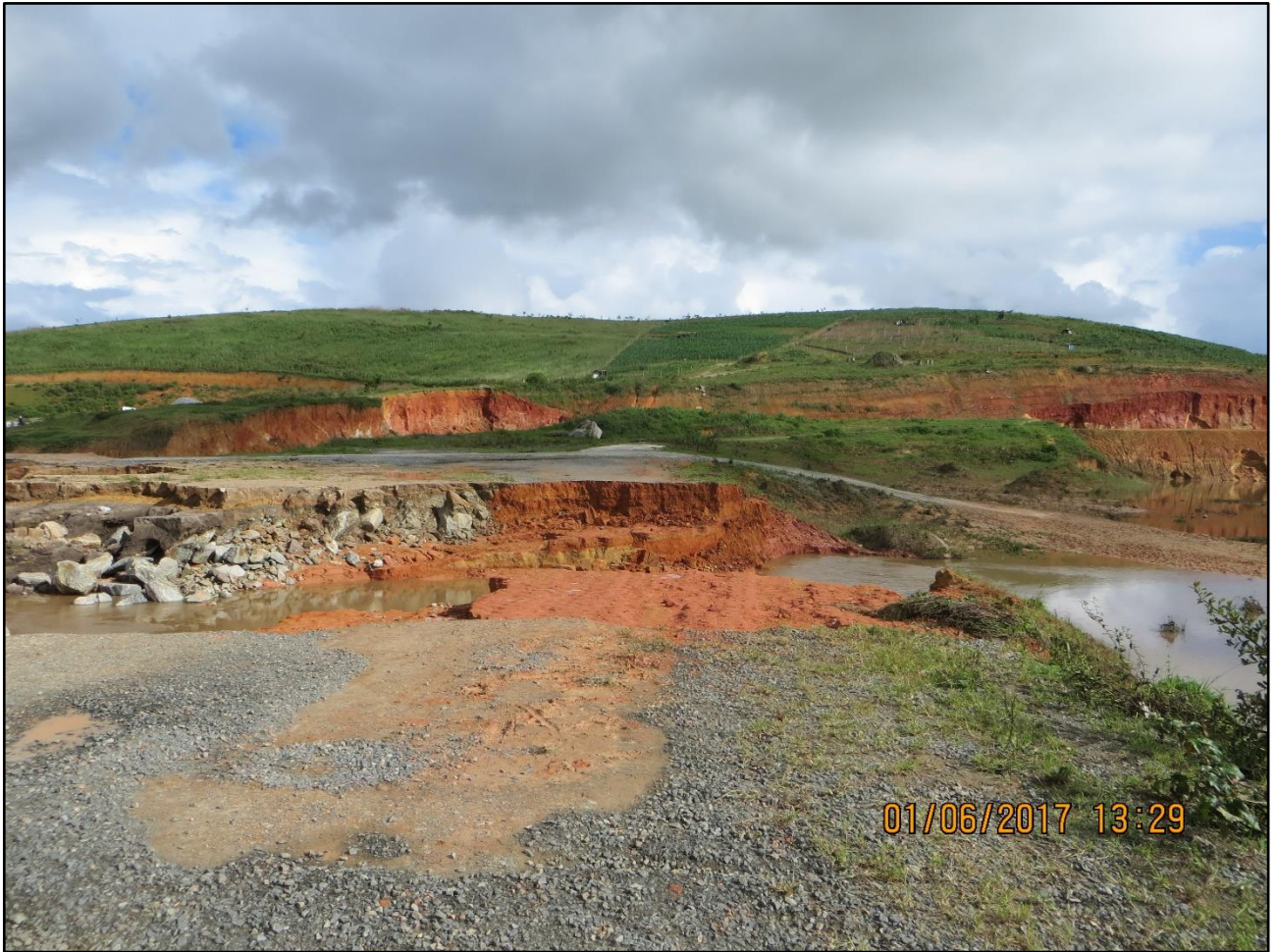
Foto 01: Barragem de Barra de Guabiraba, inacabada, rompida em três pontos, em virtude das chuvas de 05/2017. O rompimento desta barragem em 05/2017 gerou novo evento de inundação e enxurradas em Cortez-PE e Barra de Guabiraba-PE.
