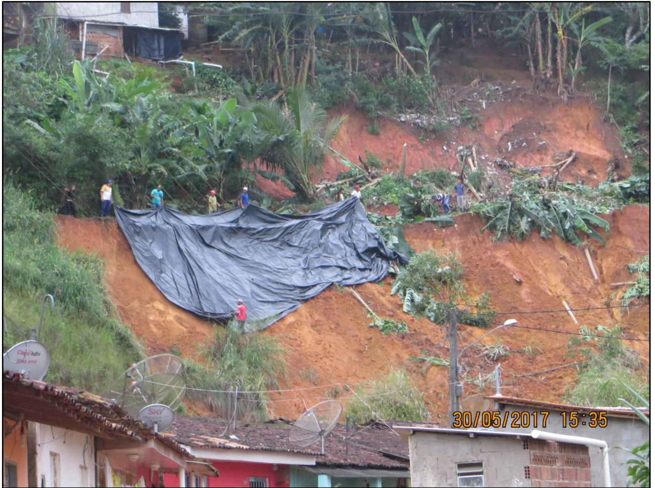
Foto 11: Lonas plásticas sendo estendidas sobre o talude de corte no patamar acima da rua do Matadouro, para impedir que a mesma seja atingida por novos deslizamentos planares.
