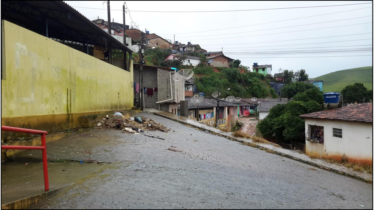
Foto 14: Largo da Emancipação (rua do Aparadouro), encosta com processos ativos de rastejo, deslizamento planar.
