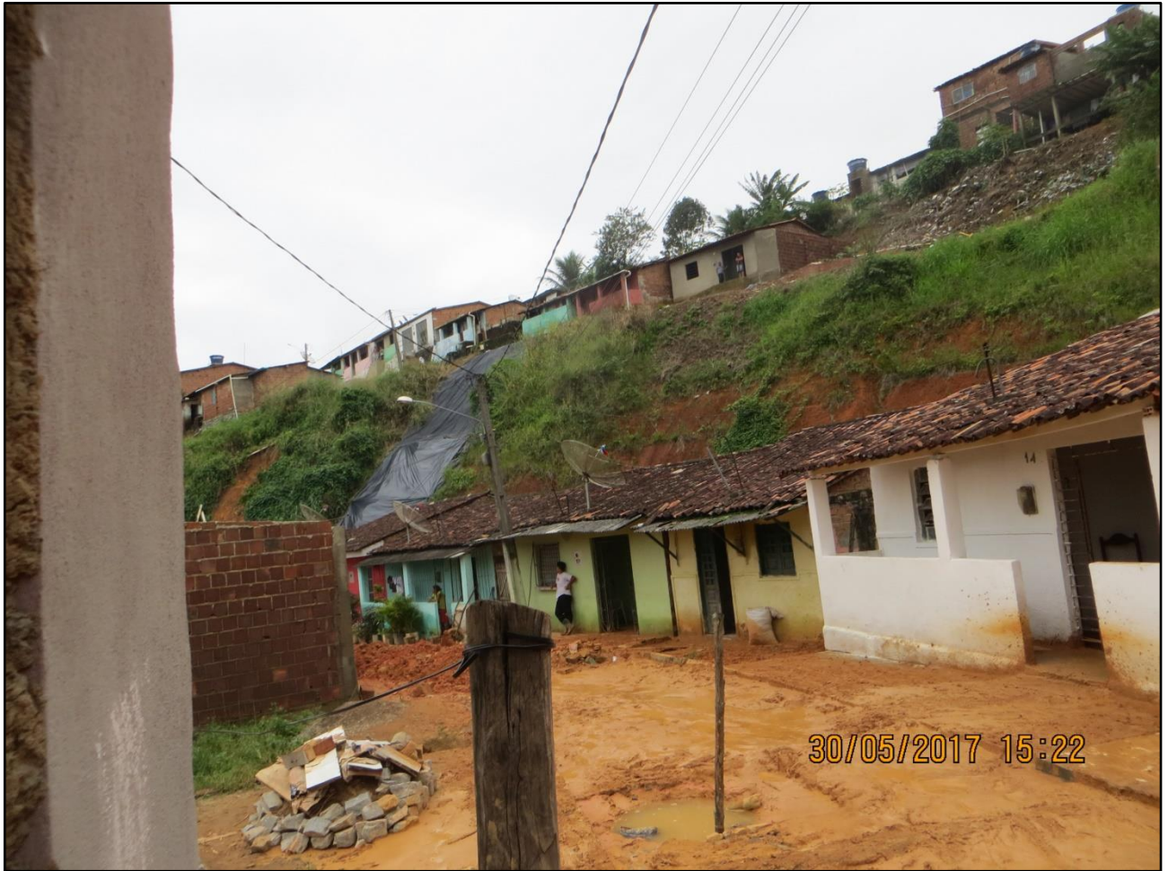
Foto 10: Visão panorâmica da encosta em patamares de corte e aterro, atingida por deslizamentos planares após as chuvas de 27 e 28 de Maio de 2017, em primeiro plano a Rua do Matadouro.
