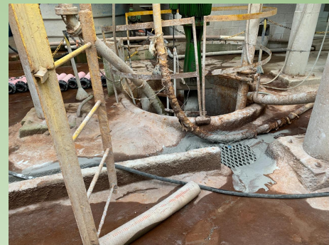
Figura 2: Direcionamento de resíduos ao poço comum.
