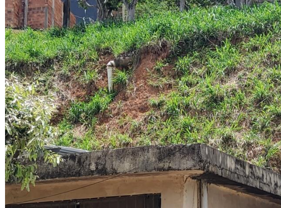
Figura 19. Junção de encanamentos onde ocorre o vazamento relatado pelos moradores.
