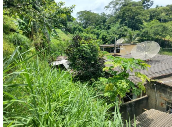
Figura 21. Talude íngreme muito próximo das residências.
