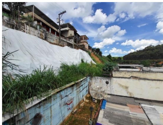
Figura 3. Encosta protegida por lona.
