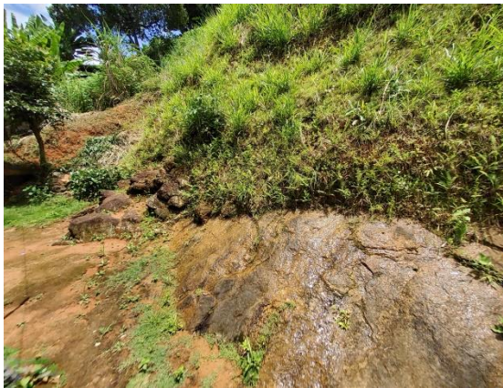
Figura 22. Água na interface entre solo e rocha, blocos em meio ao solo.
