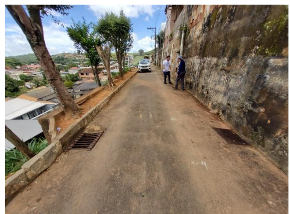
Figura 15. Drenagem na Rua Balbina de Oliveira.
