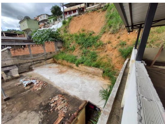
Figura 14. Vista do talude.
