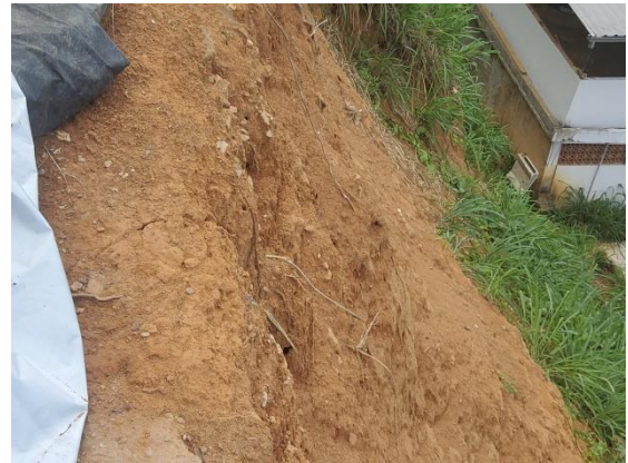
Figura 13. Aspecto do material na crista do talude.
