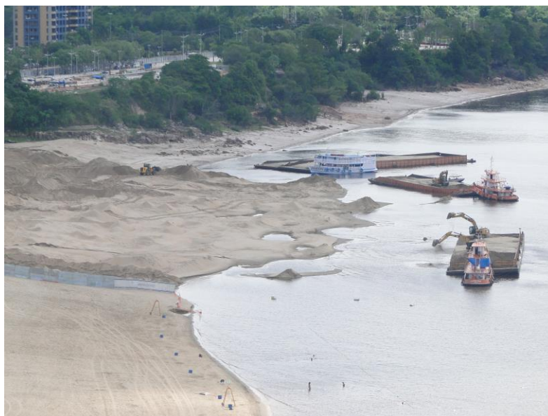
Figura 06: Lançamento de areia no leito natural através de balsas e pás mecânicas sem uso de contenção.
