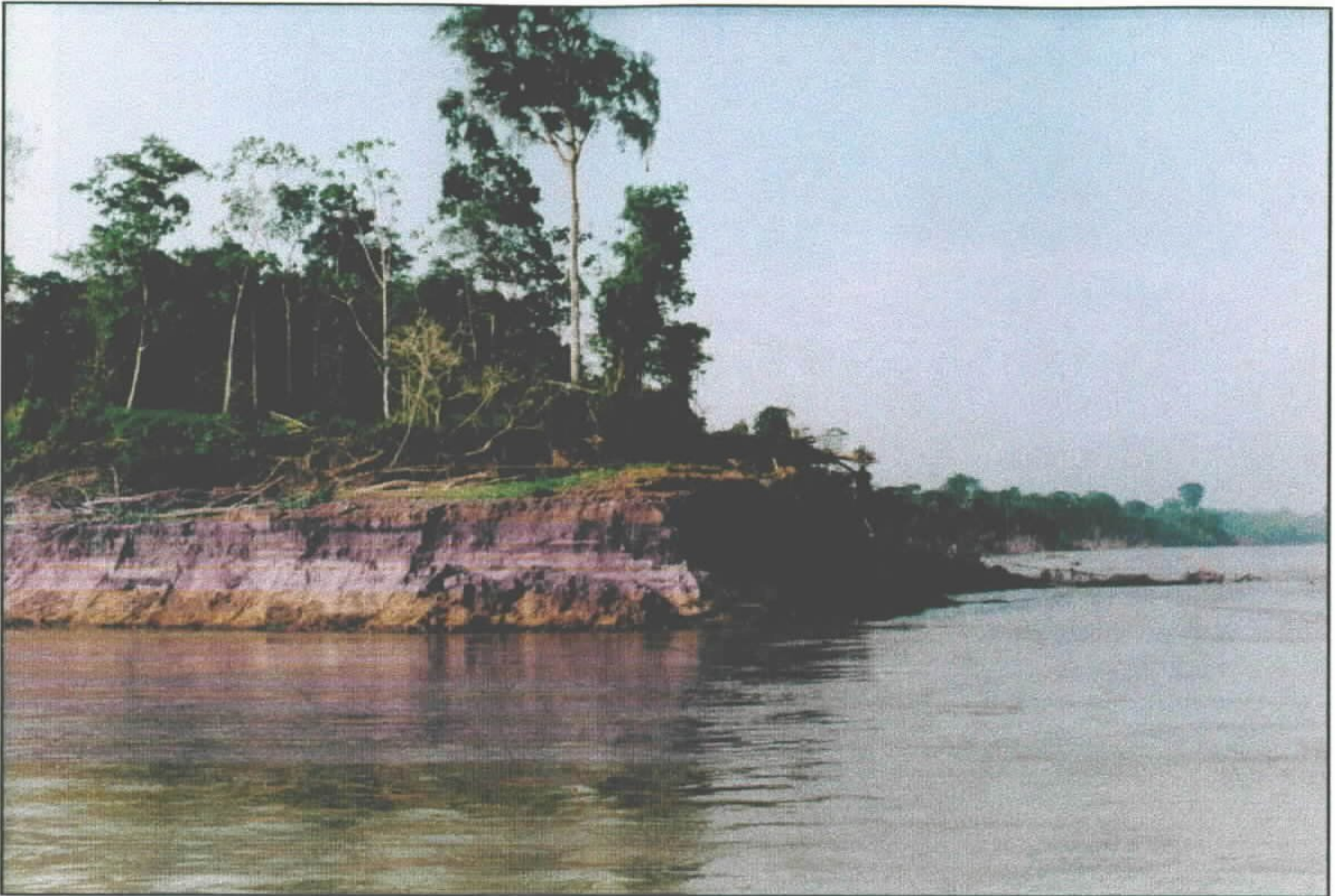
Foto 05 – Processo erosivo, com fenômeno de “terras caídas” e tombamento de árvores de médio e grande porte, provocado pela erosão hídrica em barranco de Neossolo Flúvico Eutrófico (Tropofluvents). Rio Solimões Lat. 4° 07’ S e Long. 69° 31’ W.
