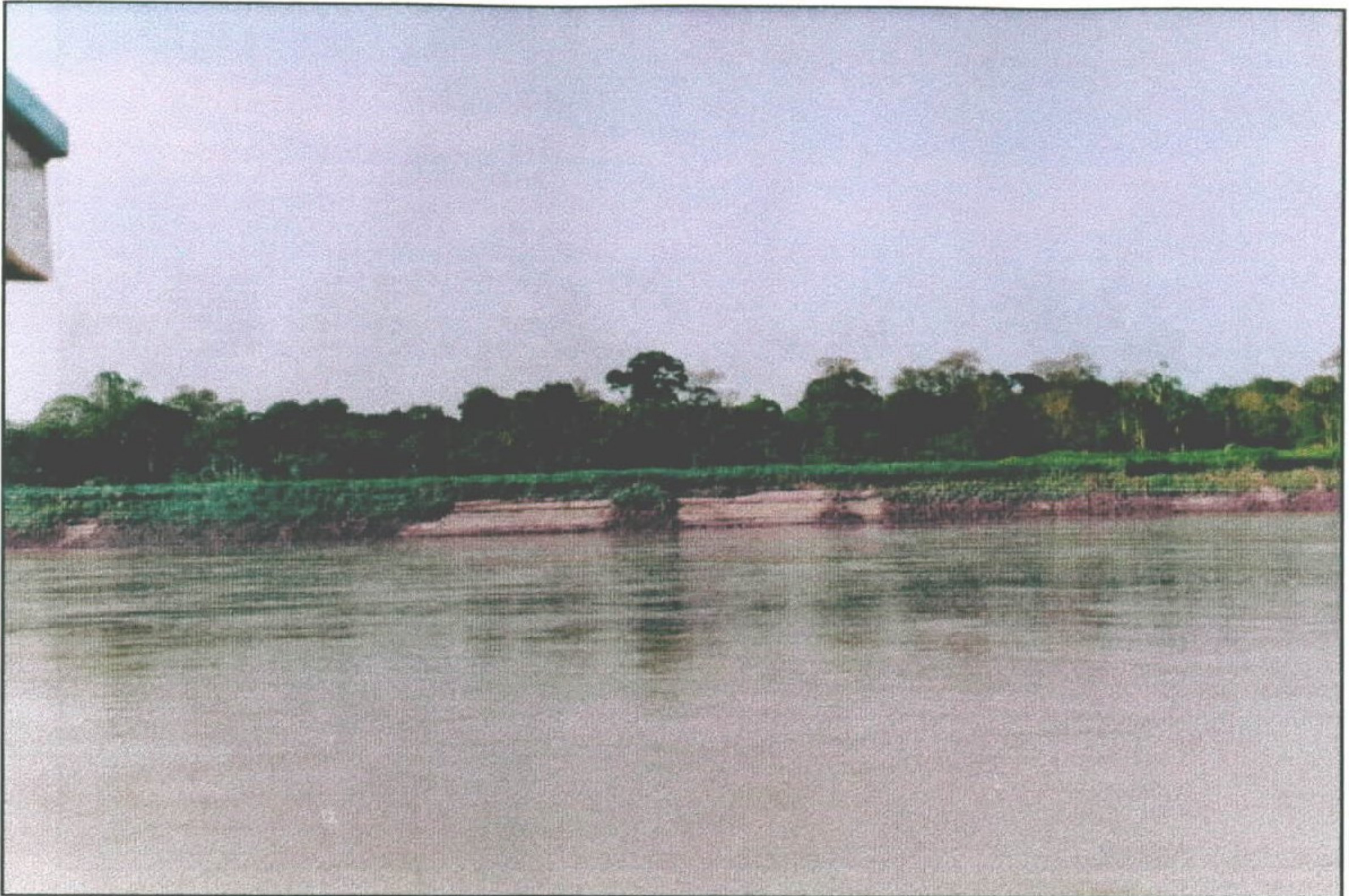
Foto 01 – Deslizamento de barranco, caracterizando processo erosivo em Neossolo Flúvico (Tropofluents). Rio Solimões. Lat. 4^{\circ} 20' S e Long. 69^{\circ} 52' W .
