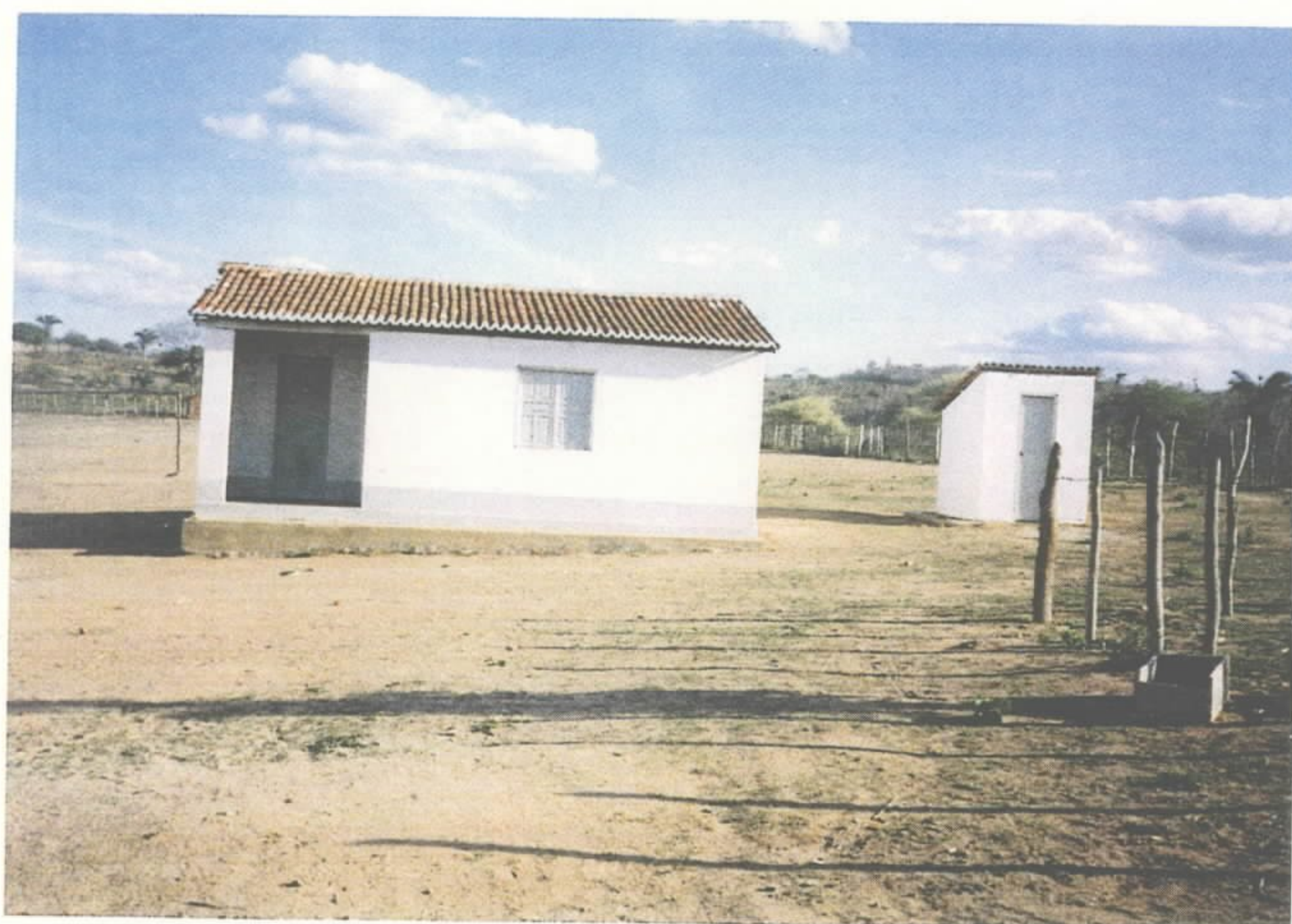
FOTO 3.8 - Prédio escolar municipal em Volta Grande.
