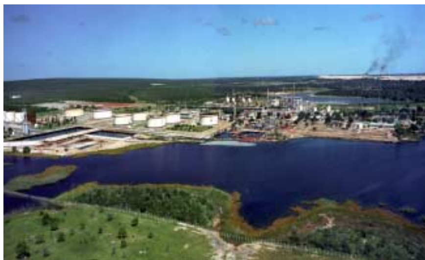
Foto 5.23 - Vista panorâmica do Pólo Industrial de Guararé.
