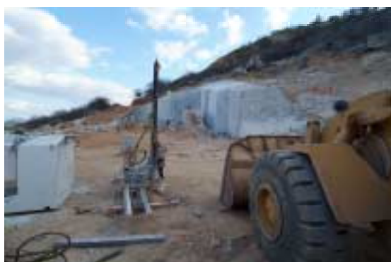
Foto 5.15 - Frente de lavra do metaconglomerado da Formação Equador (Boqueirão, Parelhas).
