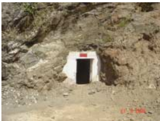
Foto 5.8 - Galeria de acesso à exploração do minério de tungstênio. Nível superior (escarnito A), setor L3 da mina Brejuí (Currais Novos)
