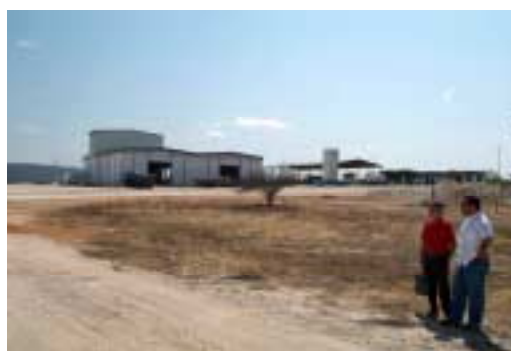
Foto 5.18 - Pátio de estocagem e instalações de beneficiamento de feldspato da empresa ARMIL (Parelhas).
