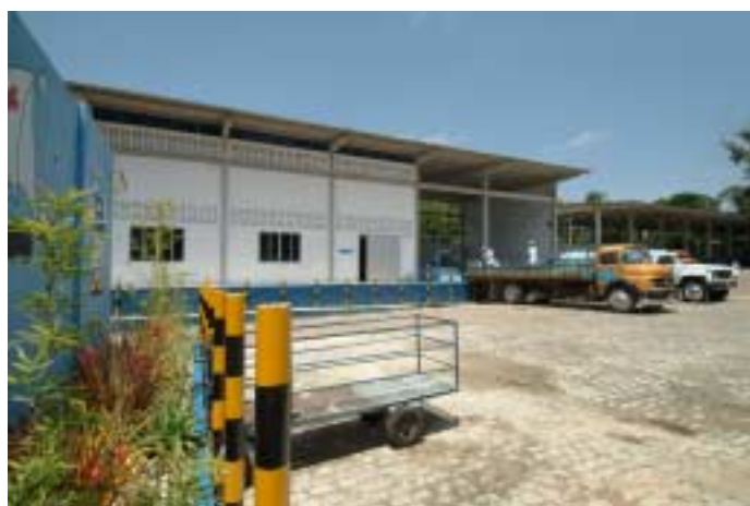
Foto 5.1 - Instalações de água mineral da Hidrominas Santa Maria (Parnamirim)
