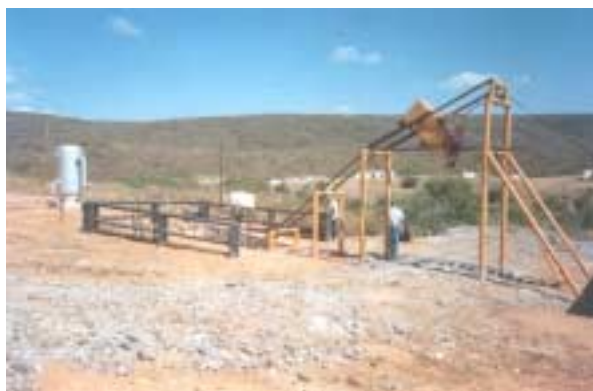
Foto 5.5 - Vista do shaft de pesquisa de ouro da mina Bonfim (Lajes).
