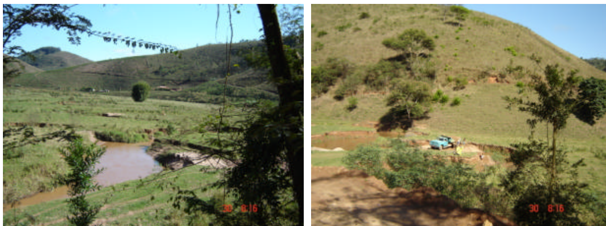
Figura 5.1: Extração de areia nas entre as cidades de Espera Feliz e Caparaó nas margens do Rio Manhuaçu. Principal produto é uma areia média para a construção civil.
