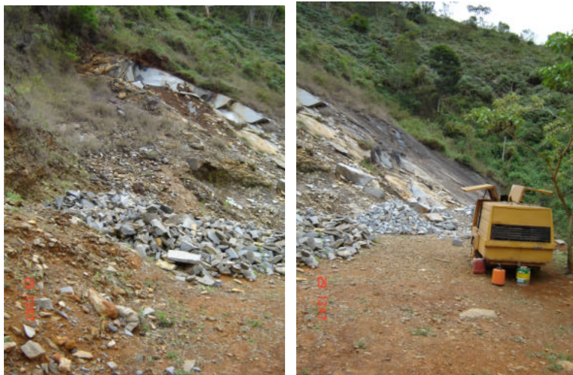
Figura 5. 57: Pedreira para paralelepipedos em rochas do Gnaiss tonalítico de Manhauçu. Devido à sua composição e à influência tectônica ele não é propício para a obtenção de placas grandes. A rocha é de granulação fina, aparentemente homogênea e cortada por veios e bandas de pegmatóides e aplitos, às vezes com allanita.
