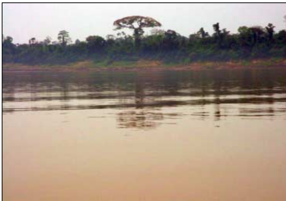
Figura 107 - Desmoronamento de barranco do rio Madeira, constituído por cobertura sedimentar (argila, silte e areia) após a atividade de dragagem, para extração de ouro, nas proximidades.
