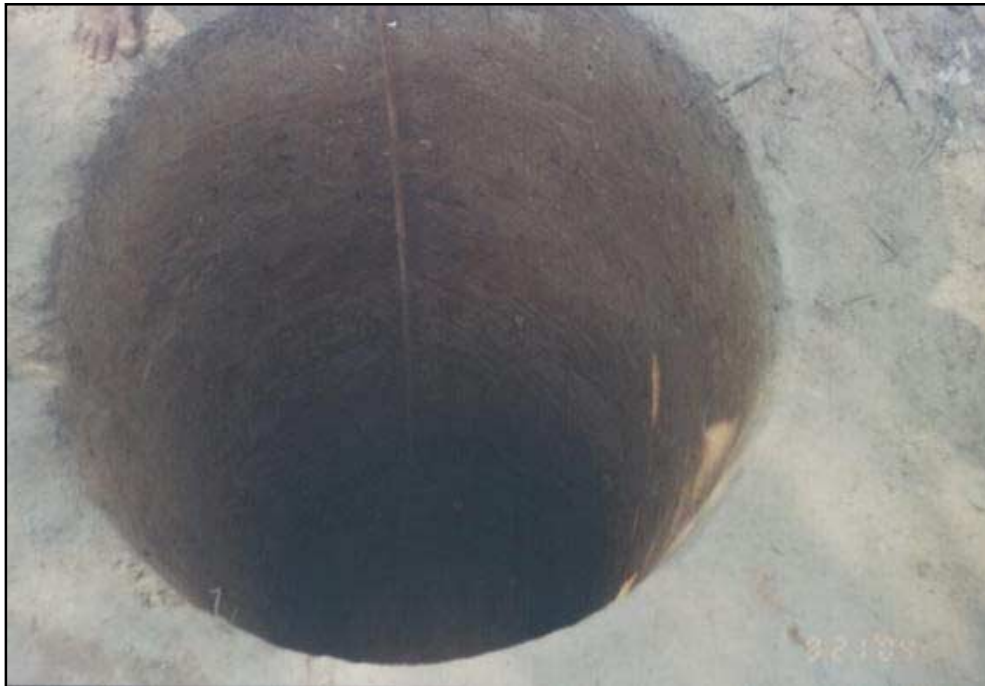
Figura 3.3 - Poço amazonas sendo escavado na vila Abunã, composto por sedimentos areno-argilosos de aquífero intergranular descontínuo, livre.
