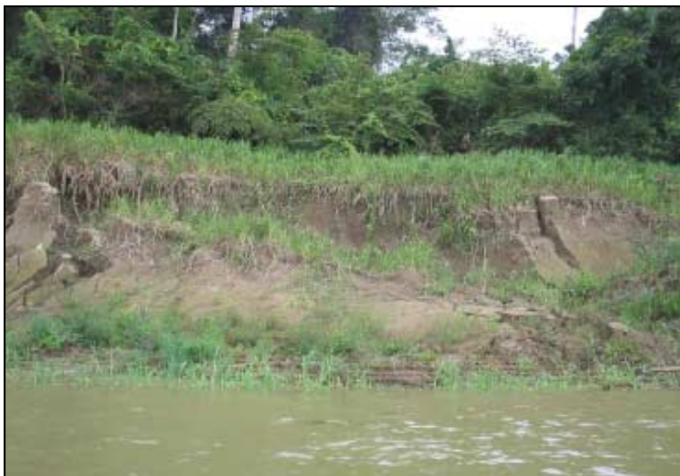
Figura 18. Solapamento e desbarrancamento de margem em talude. Próximo à foz do Igarapé Jirau.
