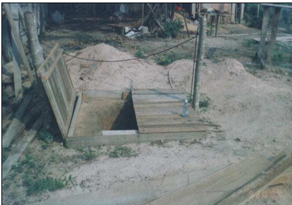
Figura 3.2 - Poço amazonas na vila Mutumparaná que explora aquífero intergranular descontínuo, livre.
