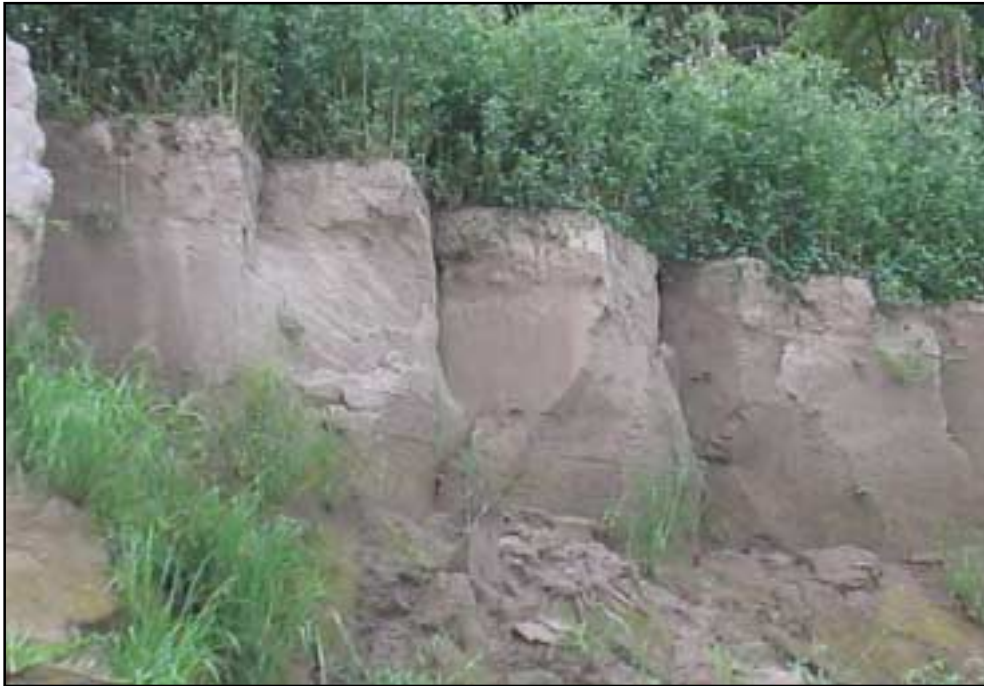
Figura 16. Fenômeno de “Terras Caídas”: desprendimentos colunares de possantes blocos de terra nas vertentes íngremes das barrancas. Ilha do Mutum-Paraná.
