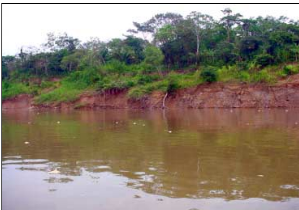
Figura 109 - Afloramento do Ponto JG-129. Desmoronamento de barranco do rio Madeira, constituído por cobertura sedimentar (argila, silte e areia) após a atividade de dragagem, para extração de ouro, nas proximidades.
