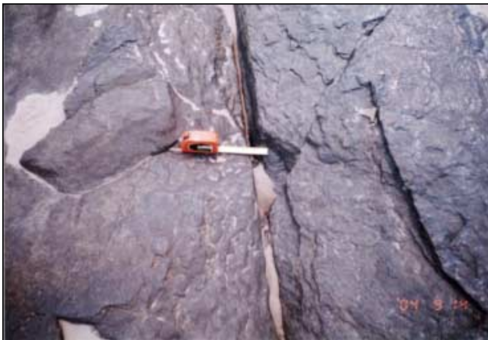
Figura 3.5 - Detalhe da fratura em litotipo de composição granítica que compõe os Aqüíferos Fraturados Descontínuos, Livres.
