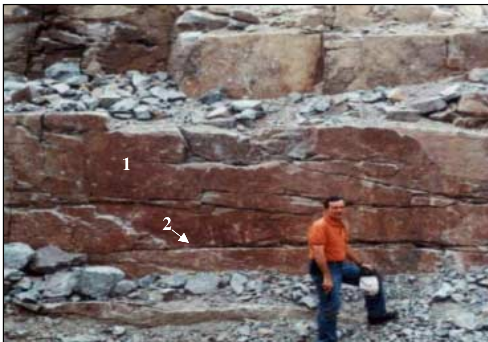
Figura 22 - Exposição no interior da cava da Pedreira da Rondomar, onde se observa plano de falha (1) com atitude segundo N 45 E /90° e fraturas subhorizontais (2) correspondentes ao alívio de pressão litostática.
