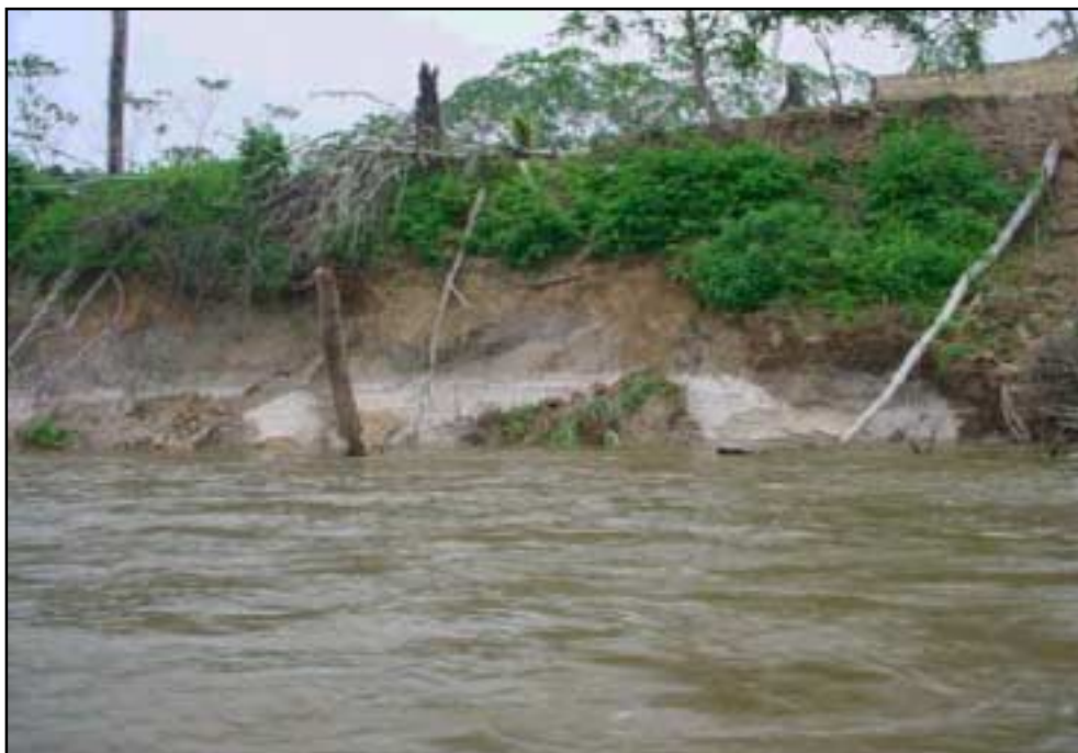
Figura 118 - Barranco na margem esquerda do rio Jaci-Paraná, próximo da sua foz, mostrando intenso processo erosivo em sedimentos arenosos friáveis.
