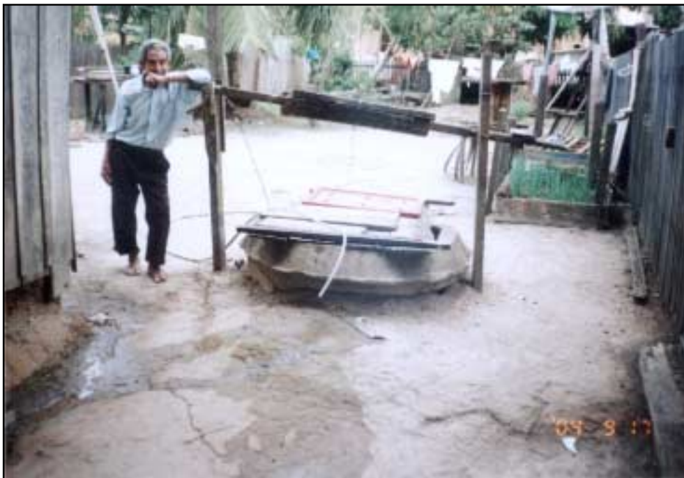
Figura 3.2 - Poço cacimba com precário sistema de bombeamento cadastrado na vila de Jaciparaná.
