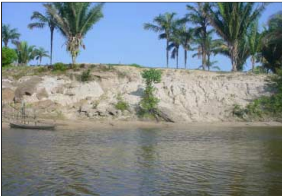
Figura 112 - Erosão provocada pela supressão da mata ciliar.
