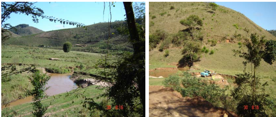
Figura 5.1: Extração de areia nas entre as cidades de Espera Feliz e Caparaó nas margens do Rio Manhuaçu. Principal produto é uma areia média para a construção civil.
