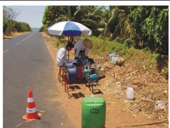
Detalhe do centro da SEV 04, exibindo as bobinas referentes aos eletrodos AB e MN, o equipamento e alguns eletrodos já fincados no solo.
