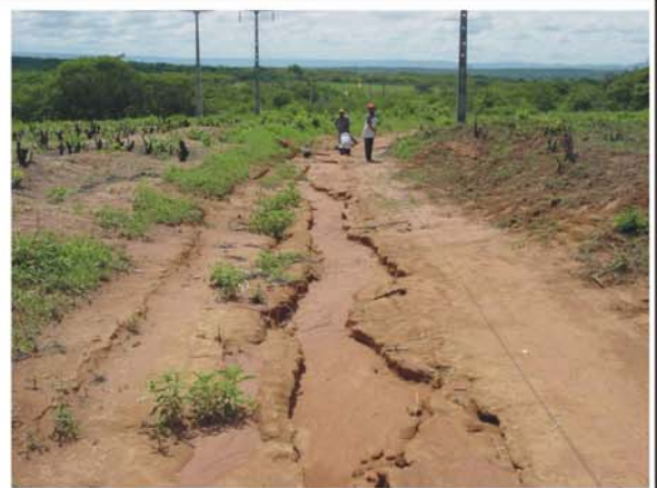
Outro trecho do Perfil de Resistividade AB.
