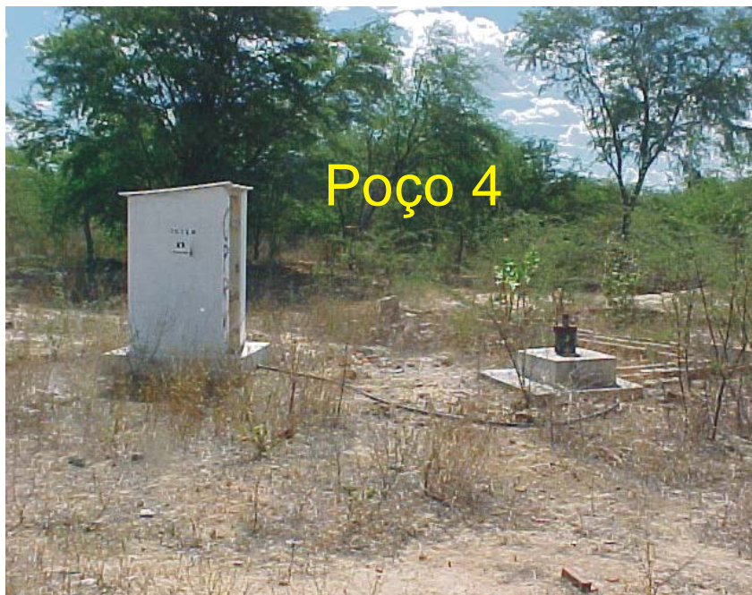
Foto 7.05. Poço nº 4, abandonado, com casa de bomba já construída.
