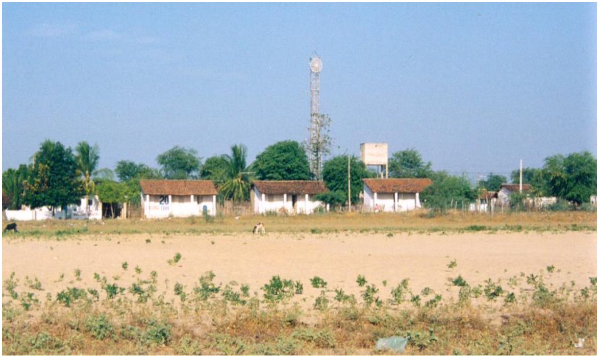
Foto 4.02. Agrovila nº 5, localizada a 7 km de Ibimirim, vendo-se a caixa d'água que recebe a água do poço localizado na sua base
