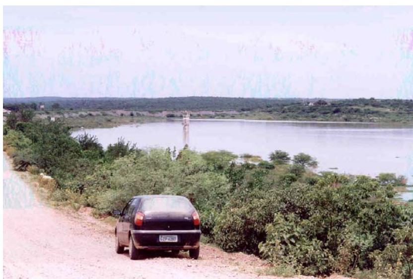
Foto 7.02. Açude Poço da Cruz em Ibimirim no mês de janeiro de 2002, na enchente do rio.
