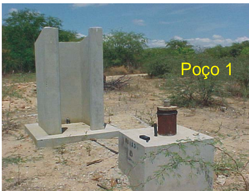
Foto 7.04. Poço nº 1, abandonado, com construção parcial da casa de bomba.
