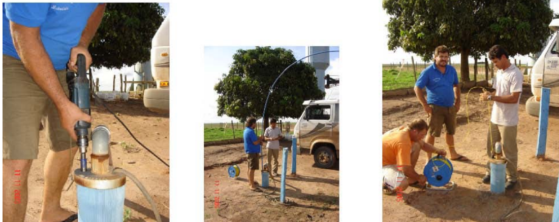
Foto 1.2. Processo de perfuração das tampas dos poços para instalação dos tubos-guia
