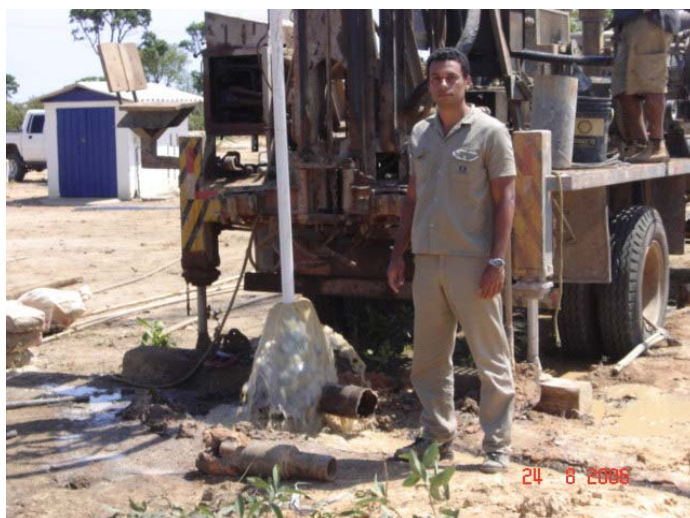
Foto 1.12. Desenvolvimento do piezômetro PO127
