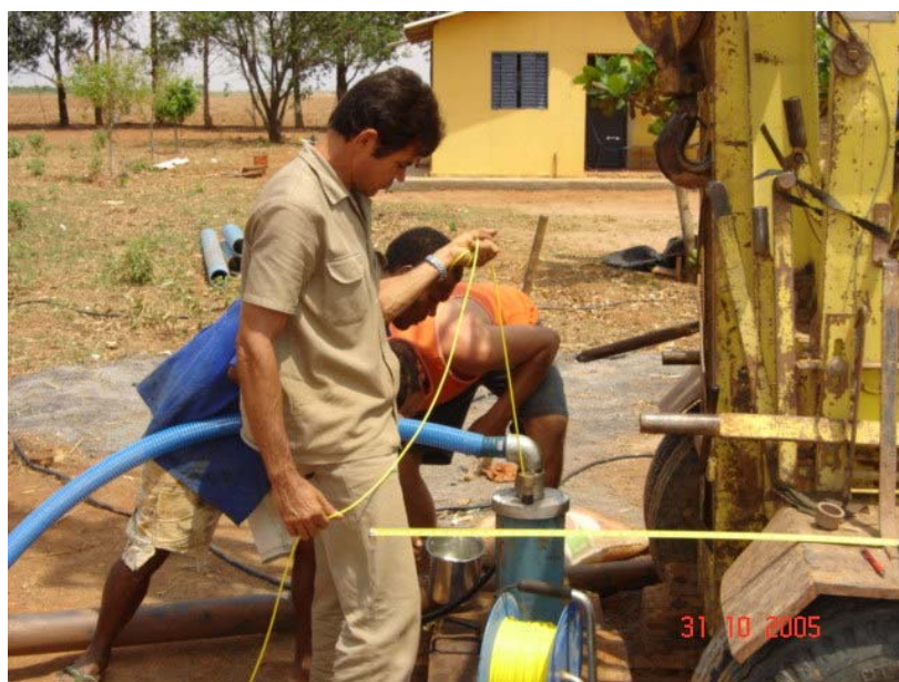
Foto 1.3. Medição no poço Pt43 que teve, posteriormente, retirados os tubos-guia
