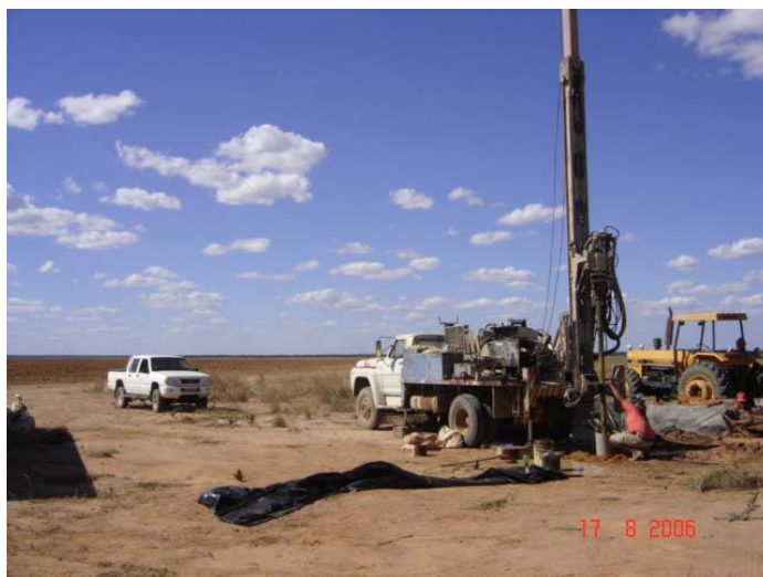
Foto 1.11. Perfuração do piezômetro PO33
