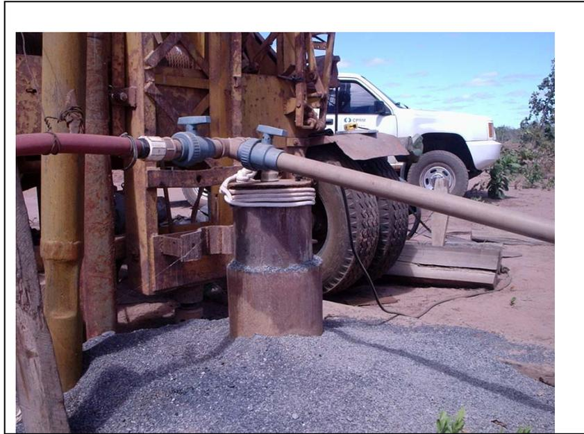
**Figura 8 - Foto do poço PT-11 localizados na Fazenda Barra dois Amores, com restos de brita calcárea utilizada como pré-filtro**
