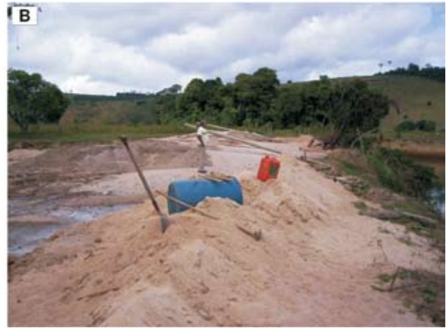
Figura 7.9. Extração de areia no leito ativo do rio São José: (a) draga; (b) área de deposição do material.
