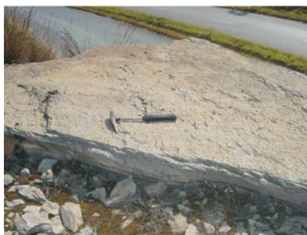
Foto 124: Níveis argilosos do Membro Pedro Leopoldo mostrando pavimento estriado por deslizamentos interestratais, com degraus ( steps ). Local: MG 424-km30 Estação: MP-373 - UTM: 606925/7822201
