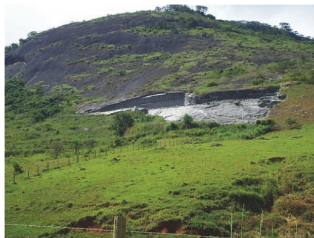
Figura 7.6 – Extração de brita, município de Natividade, RJ
