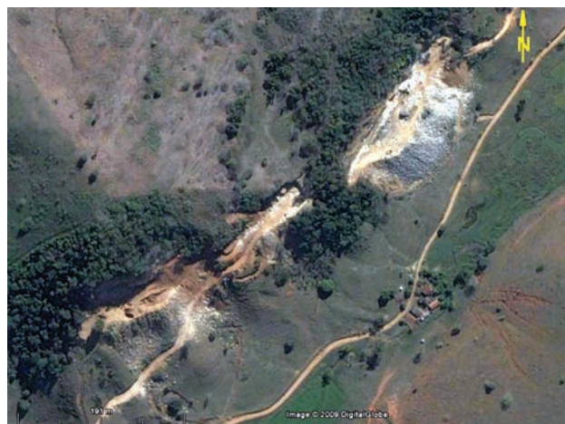
Figura 7.12 – Imagem de satélite mostrando extrações de rocha para cantaria, município de Cambuci, RJ. Imagem de satélite Google Earth, dezembro de 2008
