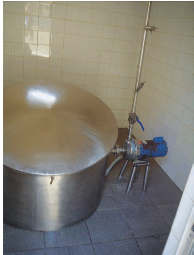
Figura 7.1 – Extração de água mineral Fazenda Santa Catarina, município de São Fidélis, detalhe da caixa de captação
