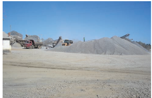
Figura 5.21 – Área de beneficiamento de calcário (M.D. Mineração) encontrada na porção oeste da Folha Curvelo 1:100.000. Norte da cidade de Curvelo. UTM N:7928767 / UTM E: 562338
