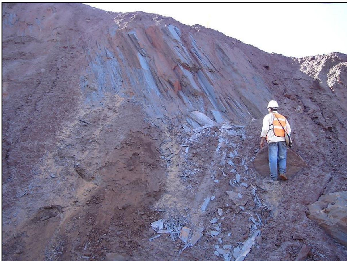
Figura 6.25 – Deslocamento devido ao bandamento do itabirito na mina São Luís.
