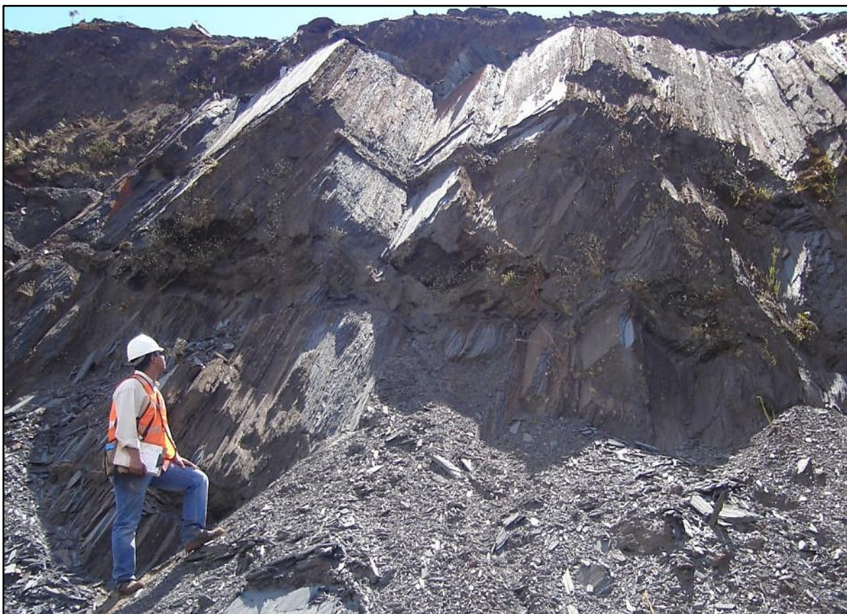
Figura 6.28 – Talude apresentando ruptura em cunha formado pela intersecção do bandamento ( S_b ) com o plano de fratura F_3 .
