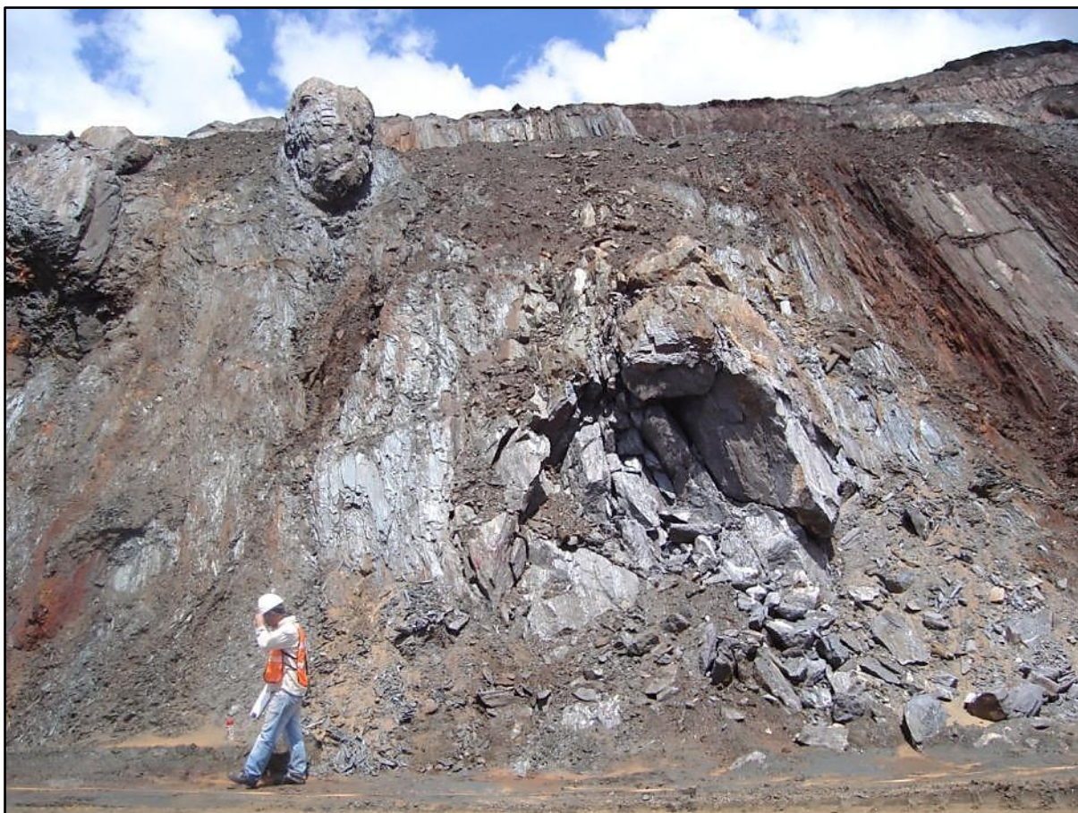
Figura 6.11 – Talude apresentando núcleos de itabirito compacto (RS).
