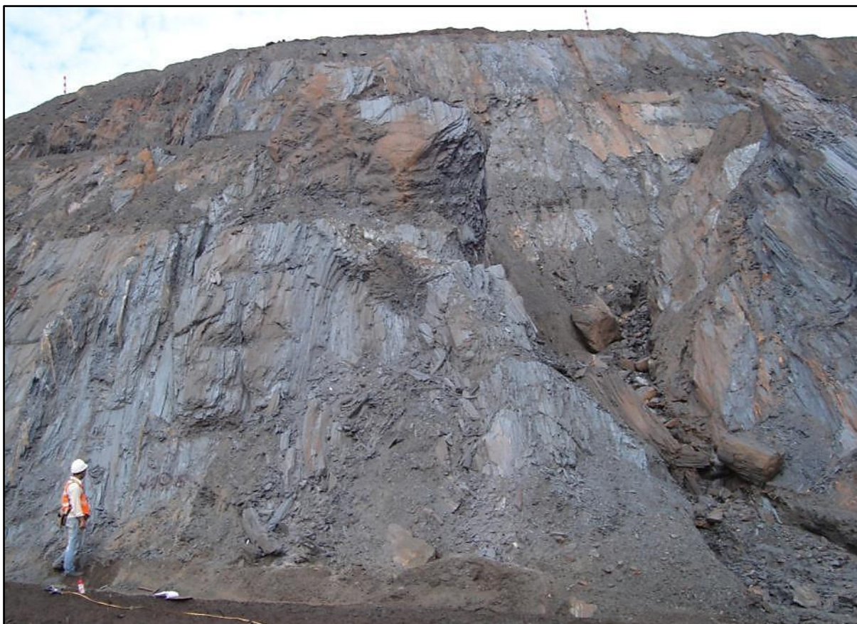
Figura 6.7 – Detalhe de uma erosão, que destruiu totalmente o acesso da bancada superior.
