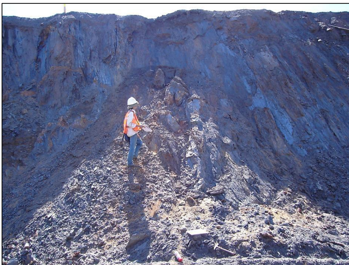
Figura 6.31 – Rompimento circular observado na mina São Luís.
