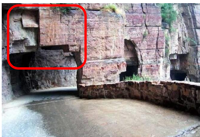
Figura 24 – Túnel de Guoliang, China. Em destaque um bloco praticamente segregado do maciço rochoso (Foto de autor desconhecido).
