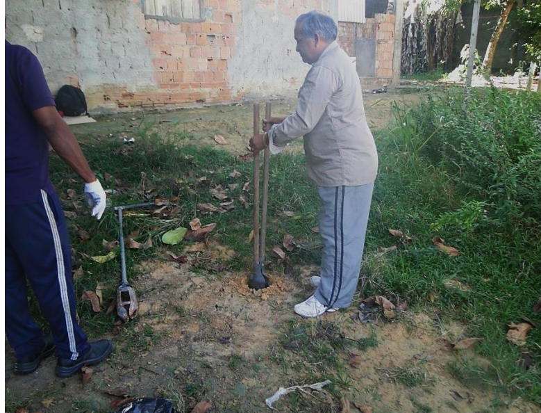
Figura 04 - Início da sondagem a trado, no dia 15/07/2013, utilizando cavadeira, trado tipo concha no chão a esquerda. Local: Ponto ST-01, bairro Jorge Teixeira. Foto do Autor
