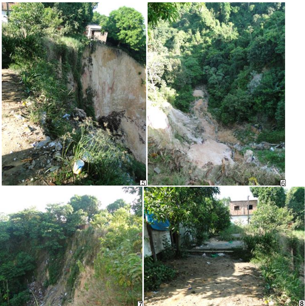
Figura 44 – Fotos ponto JT2. 5 – Casa próxima da voçoroca. 6 – Direção do fluxo de escavação da voçoroca com igarapé assoreado. 7 – Voçoroca com lixo e entulho na encosta, casa próxima. 8 – Laje de casa já removida do local, caminho preferencial da água e tubulação danificada. Fotos do Autor.
