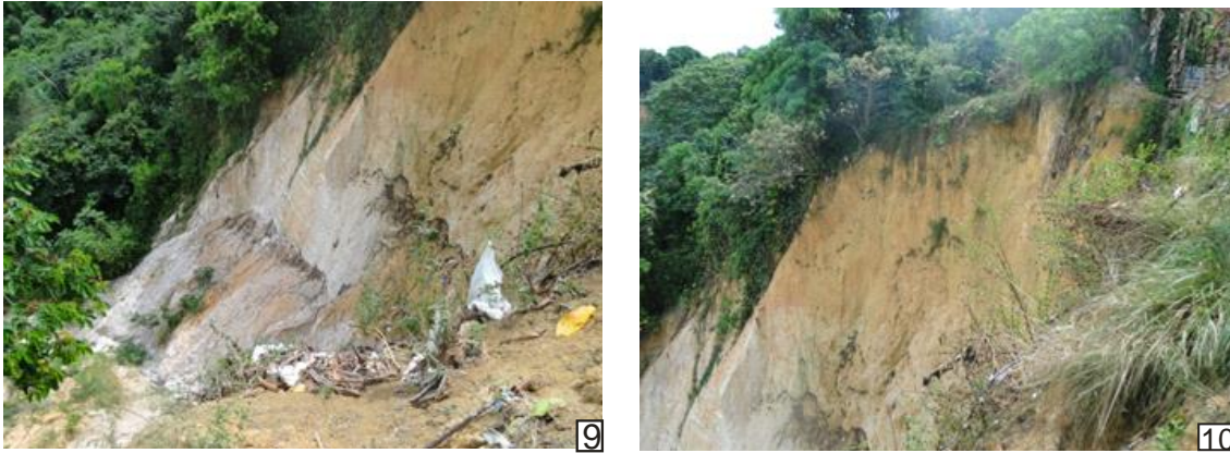
Figura 45 - Fotos 9 e 10 – Imagem do ponto JT3. 9 – Voçoroca com paredes íngremes, visualização dos horizontes argiloso e saprolítico. 10 – Voçoroca com cicatrizes na parede, indicando um próximo deslizamento. Fotos do Autor
