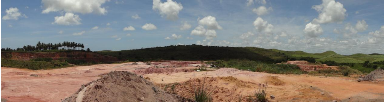
Figura 35. Área exposta à erosão devido a extração de material para construção.
