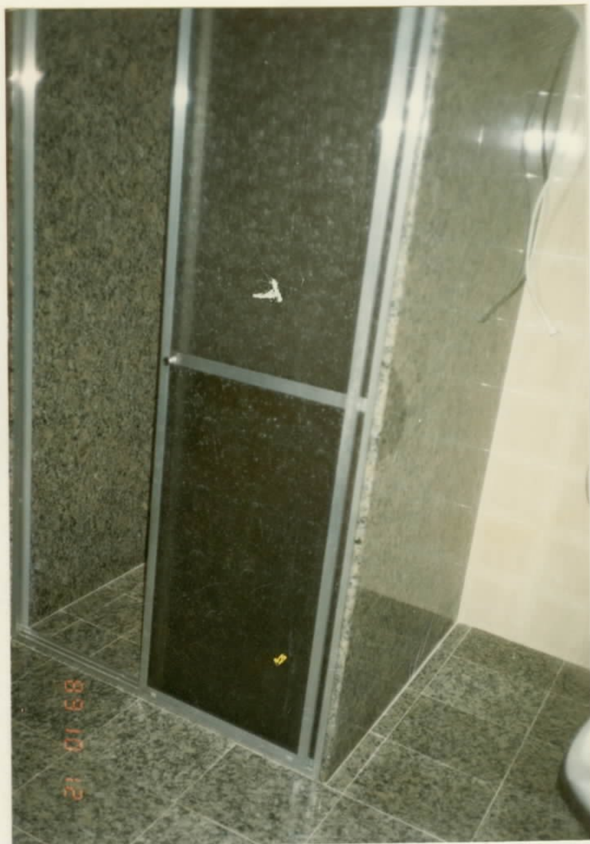
Foto 24: detalhe do "box" do baheiro do refeitório da CIGRAMAR, com peças produzidas pe la empresa.
