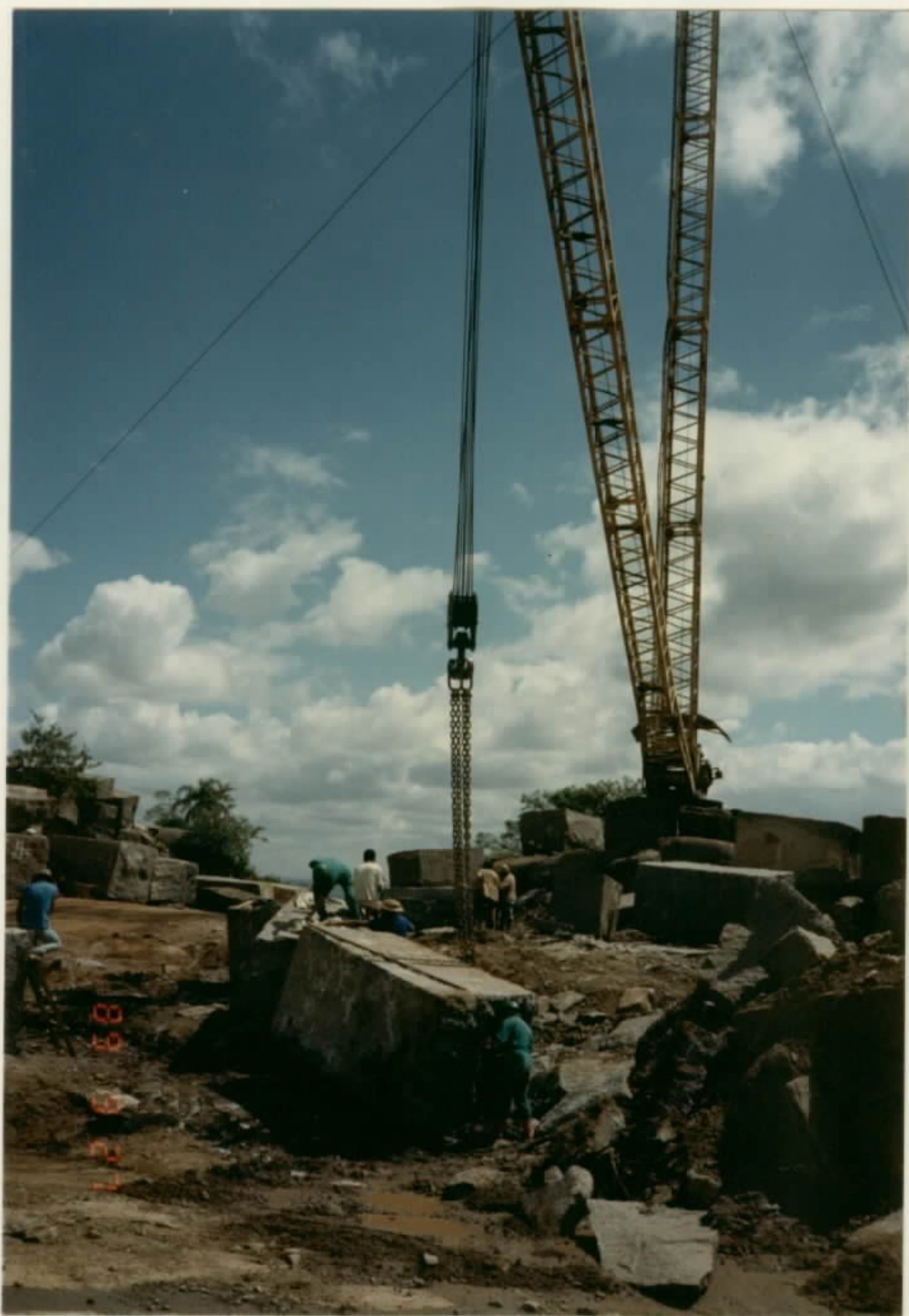
Foto 11: guindastes deslocando bloco para acabamento final.
