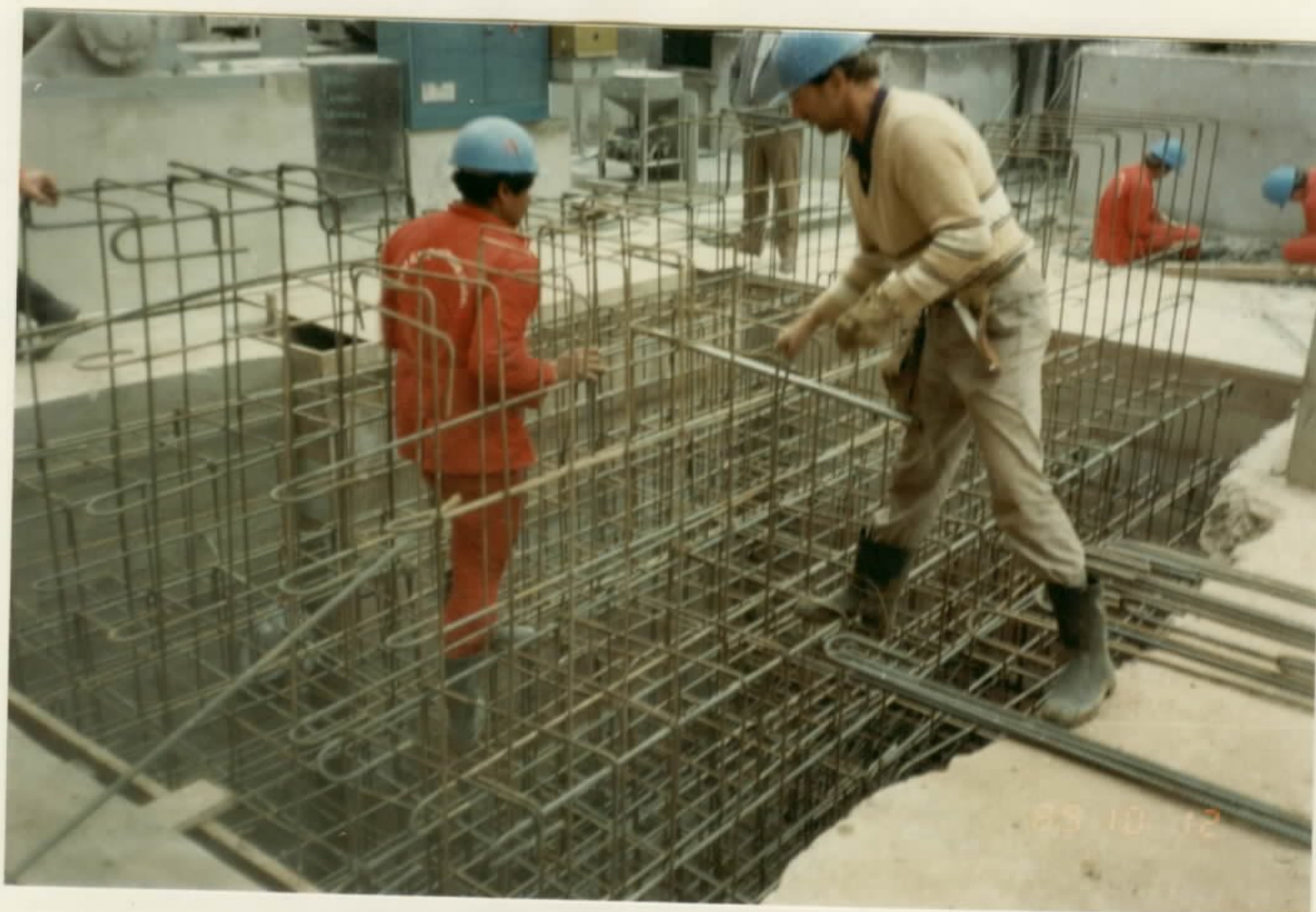
Foto 16: conserto de base de tear.
