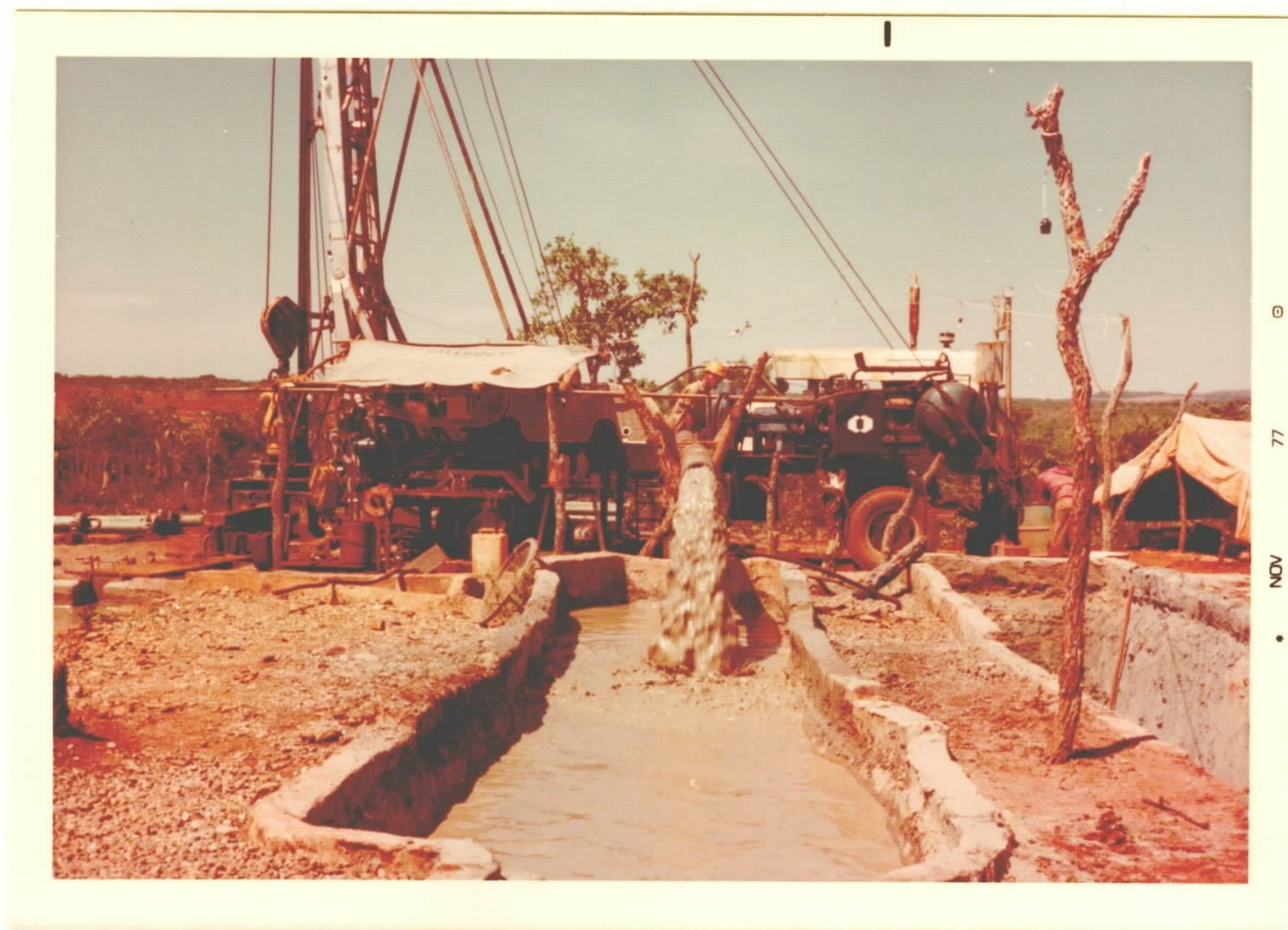
Foto 2 : Sonda FA 12. Lama e rocha quimberlítica são lançadas diretamente nos tanques.
