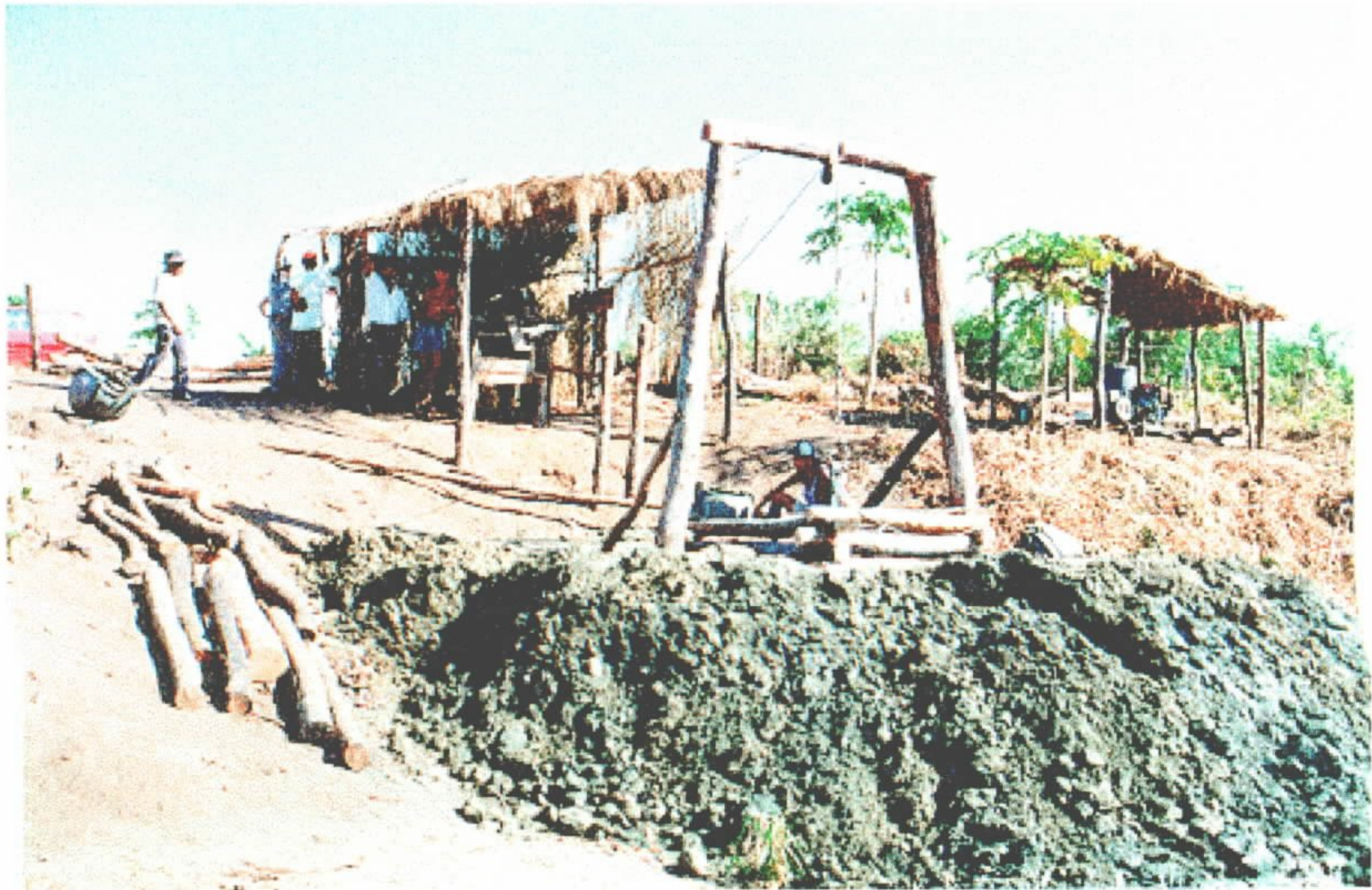
Foto 3 - Perfuração de poços com o auxílio de guinchos elétricos e bombas de sucção.
