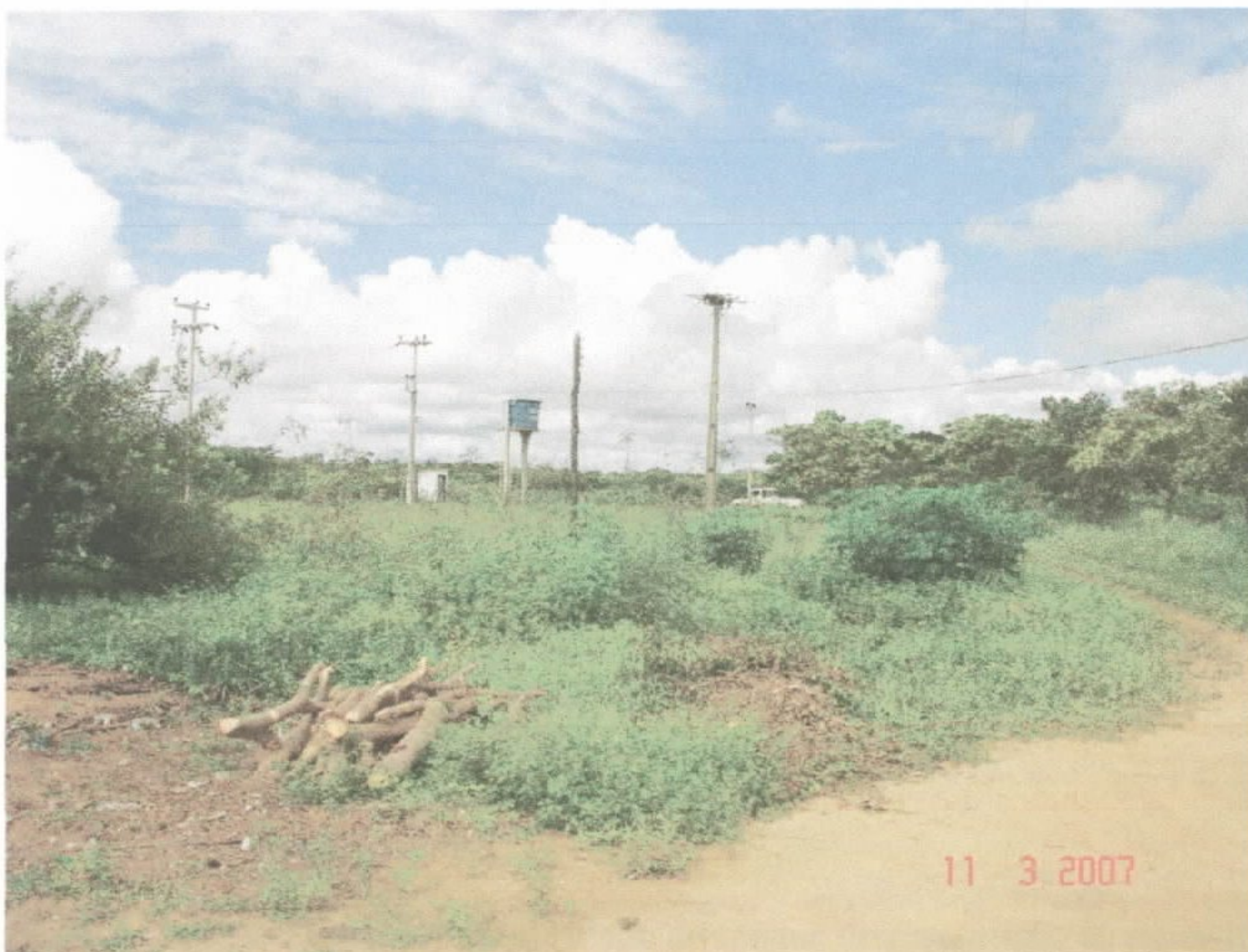
Vista panorâmica do Sistema Simplificado de Captação e Distribuição de água subterrânea captada pelo poço cadastrado pela CPRM com a sigla: GU222.
