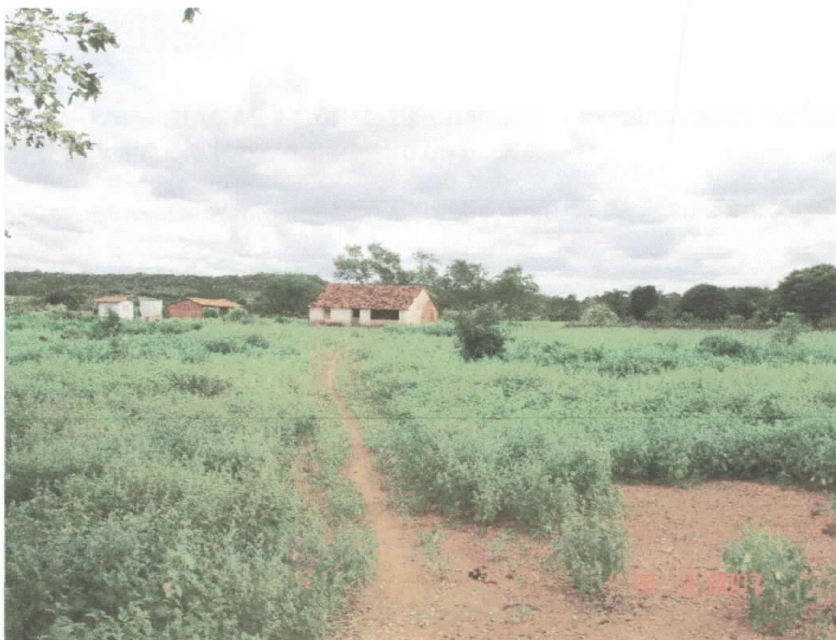
Vista panorâmica do pátio aberto onde se encontra o Sistema Simplificado de Captação e Distribuição de água subterrânea de Cansanção.
