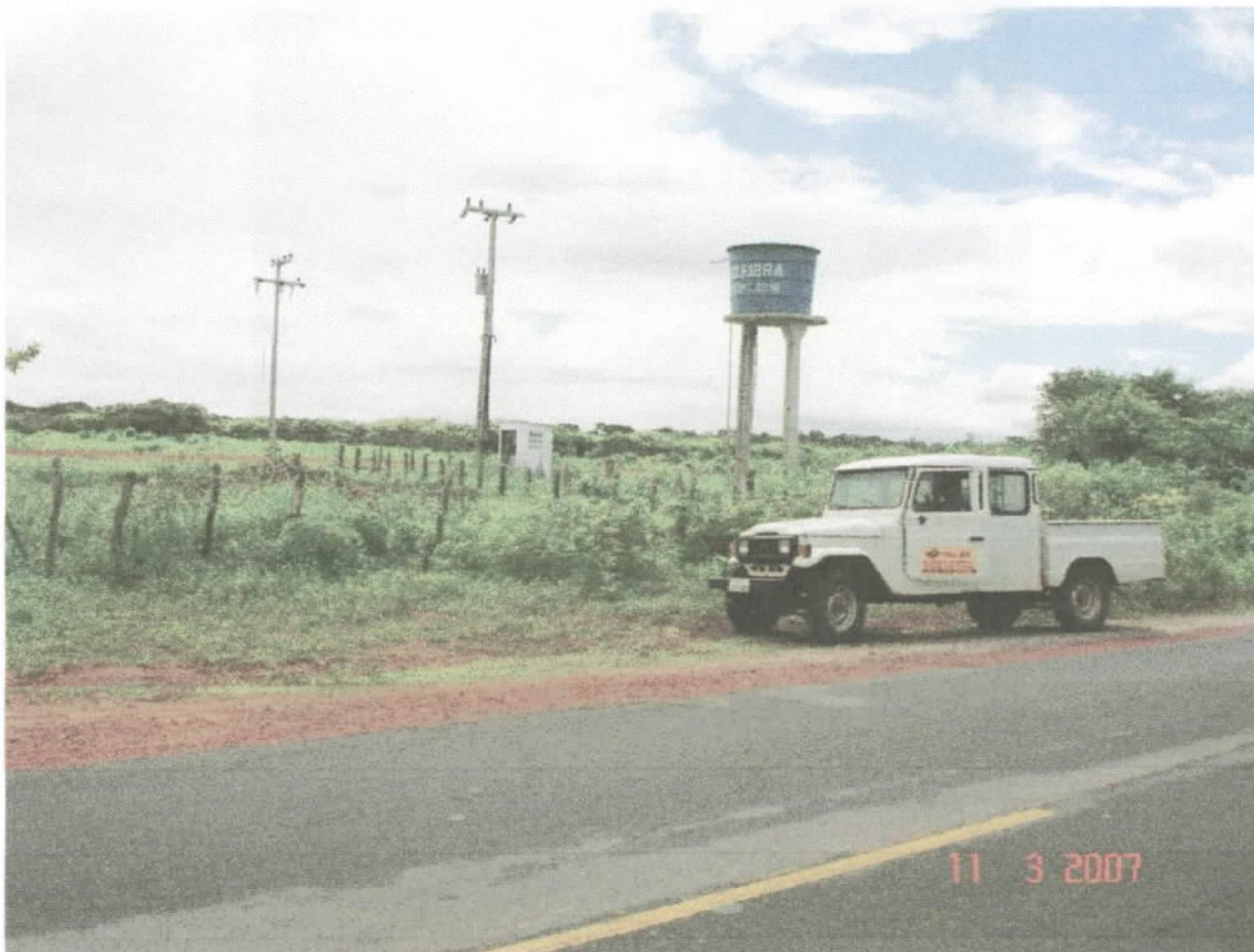
Vista panorâmica do Sistema Simplificado de Captação e Distribuição de água subterrânea captada pelo poço cadastrado pela CPRM com a sigla: GU222.
