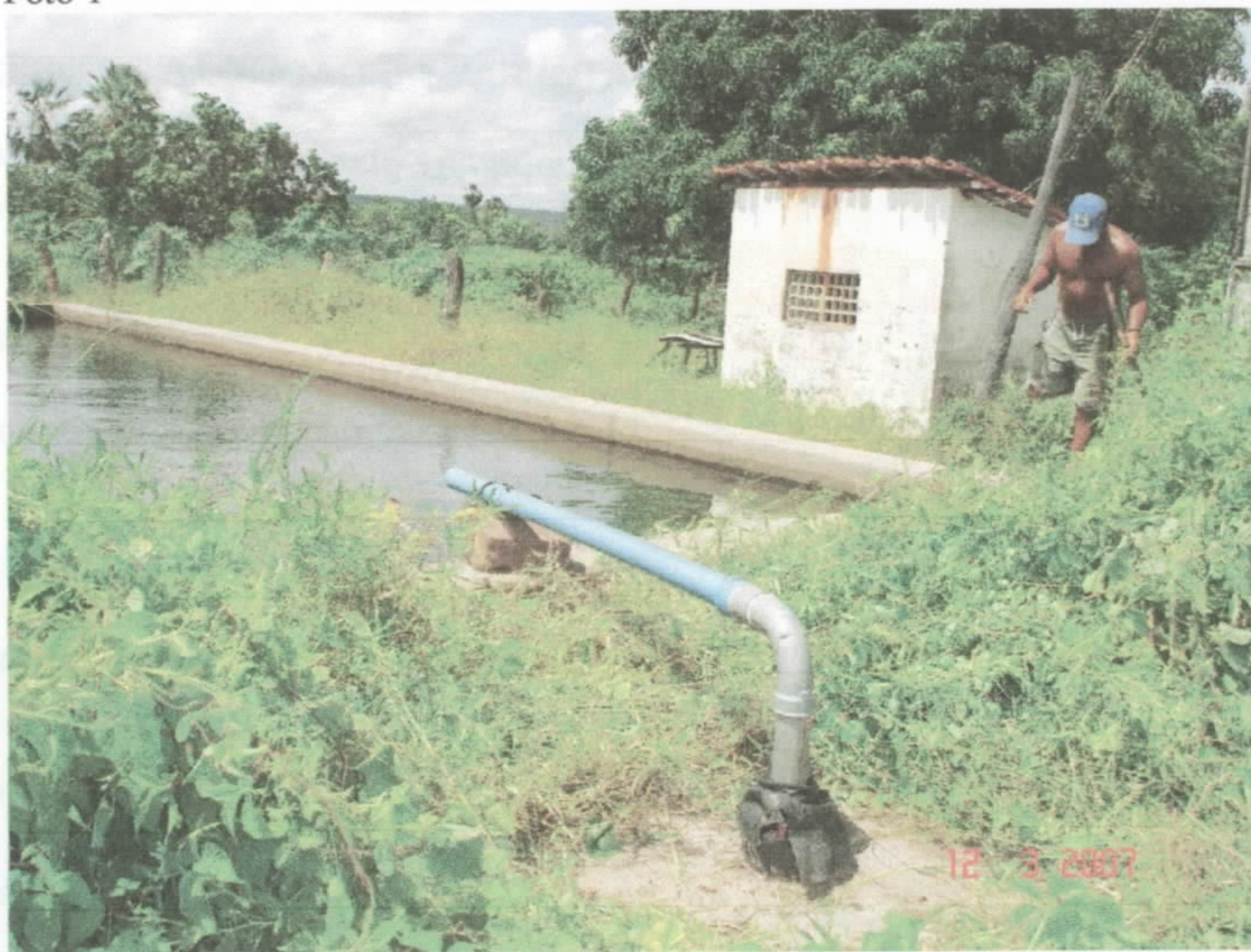
Poço 3 - localizado a 10 metros do poço 2 e a 30 metros de poço 1. Abastece com auxílio do poço 2 o tanque que fornece água a horta comunitária.
