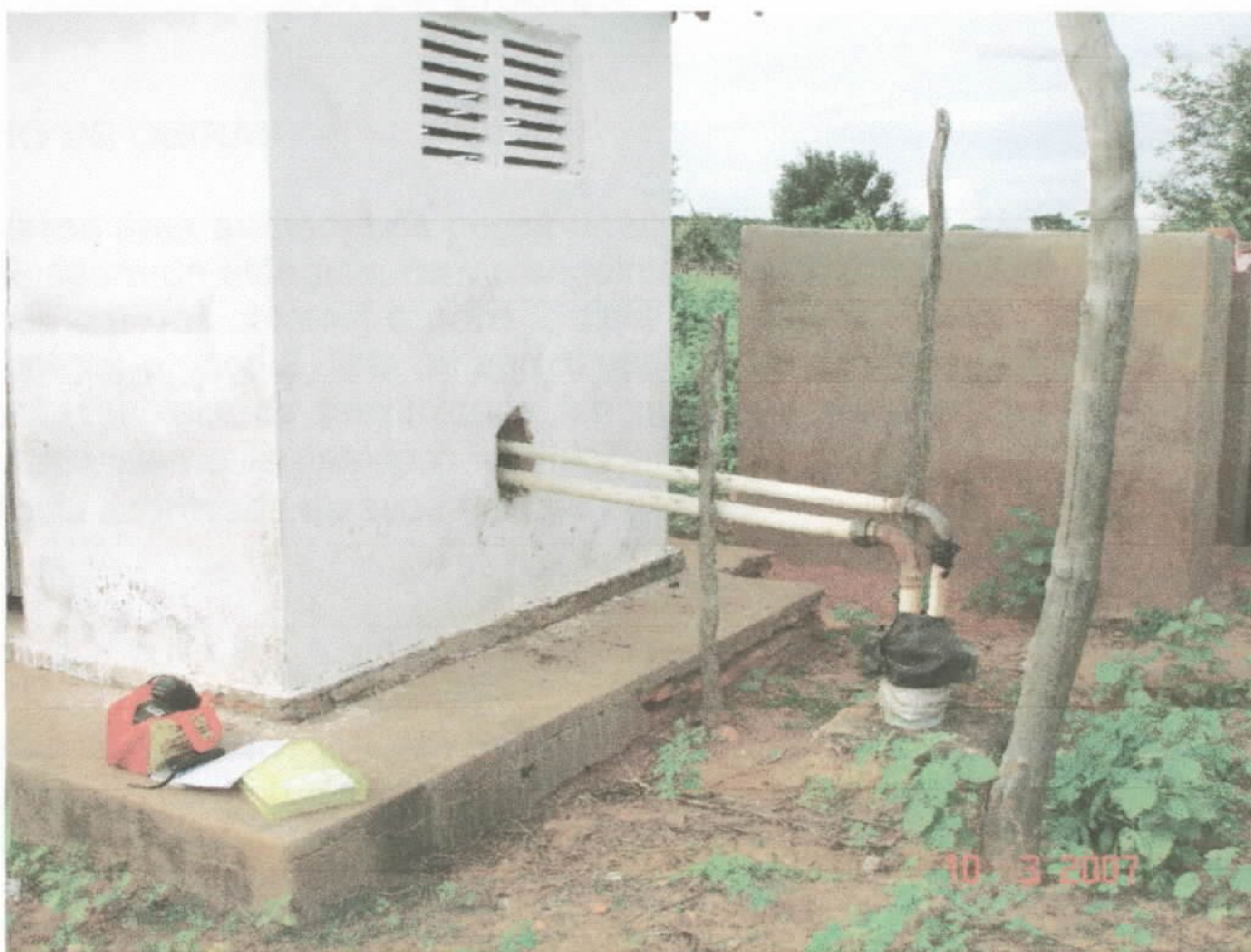
Boca do poço parcialmente fechada.
