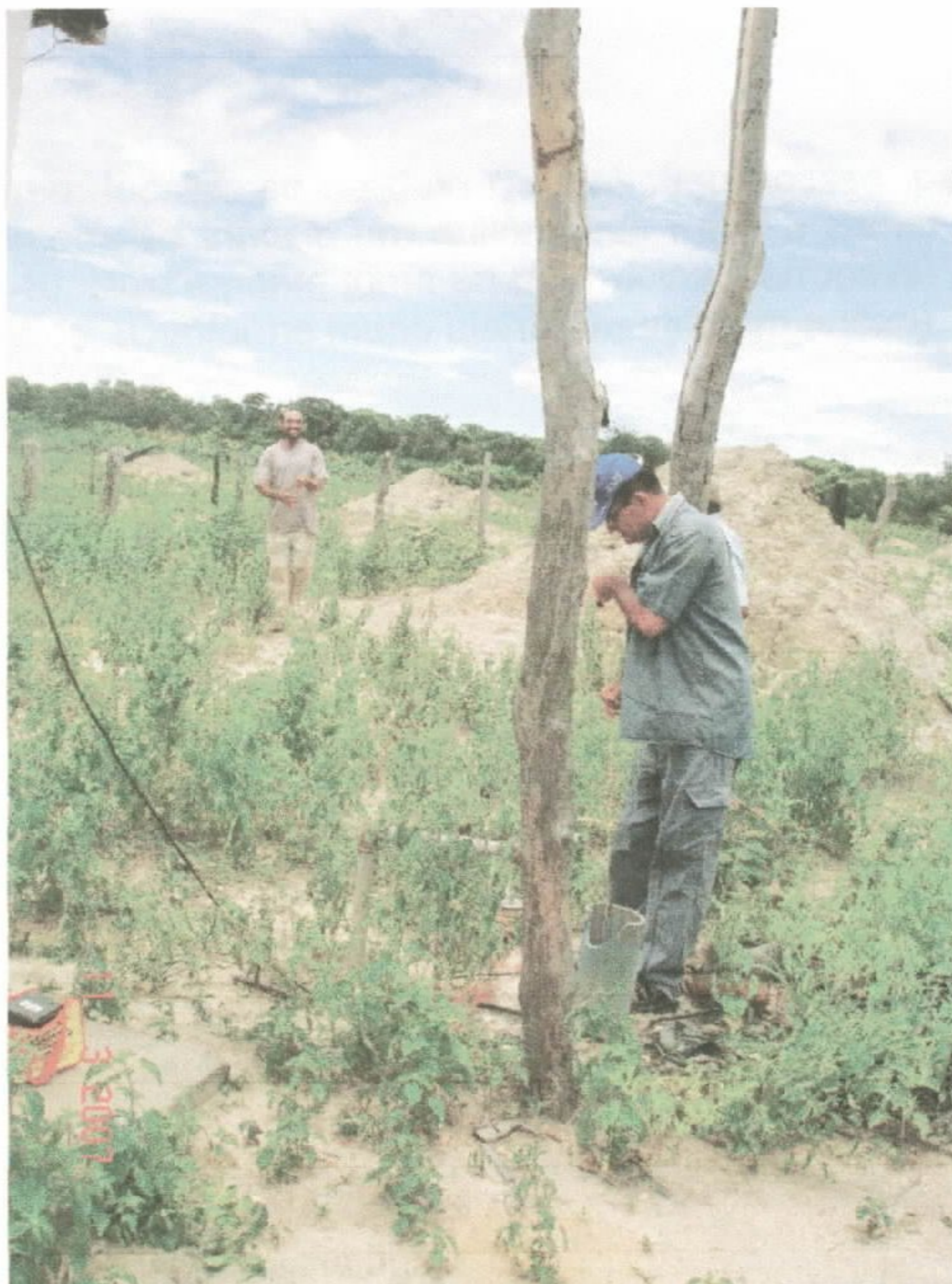
Operação de medição do Nível Estático do poço GU086.
