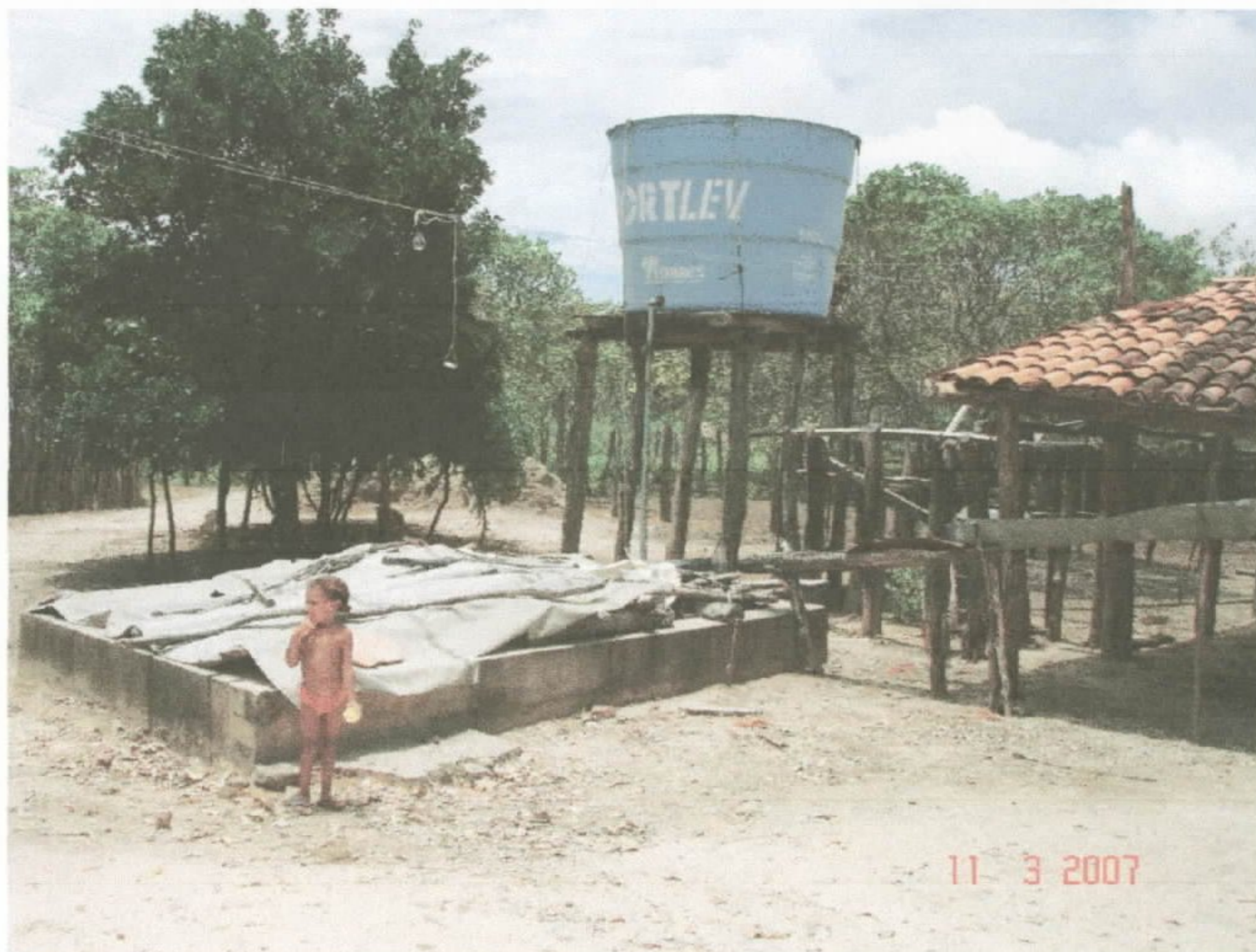
Vista panorâmica da precariedade e insalubridade da captação das águas de chuva e do tanque de reservação da água utilizada pelo assentado. Durante o período de seca ele se abastece comprando água de caminhão pipa.
