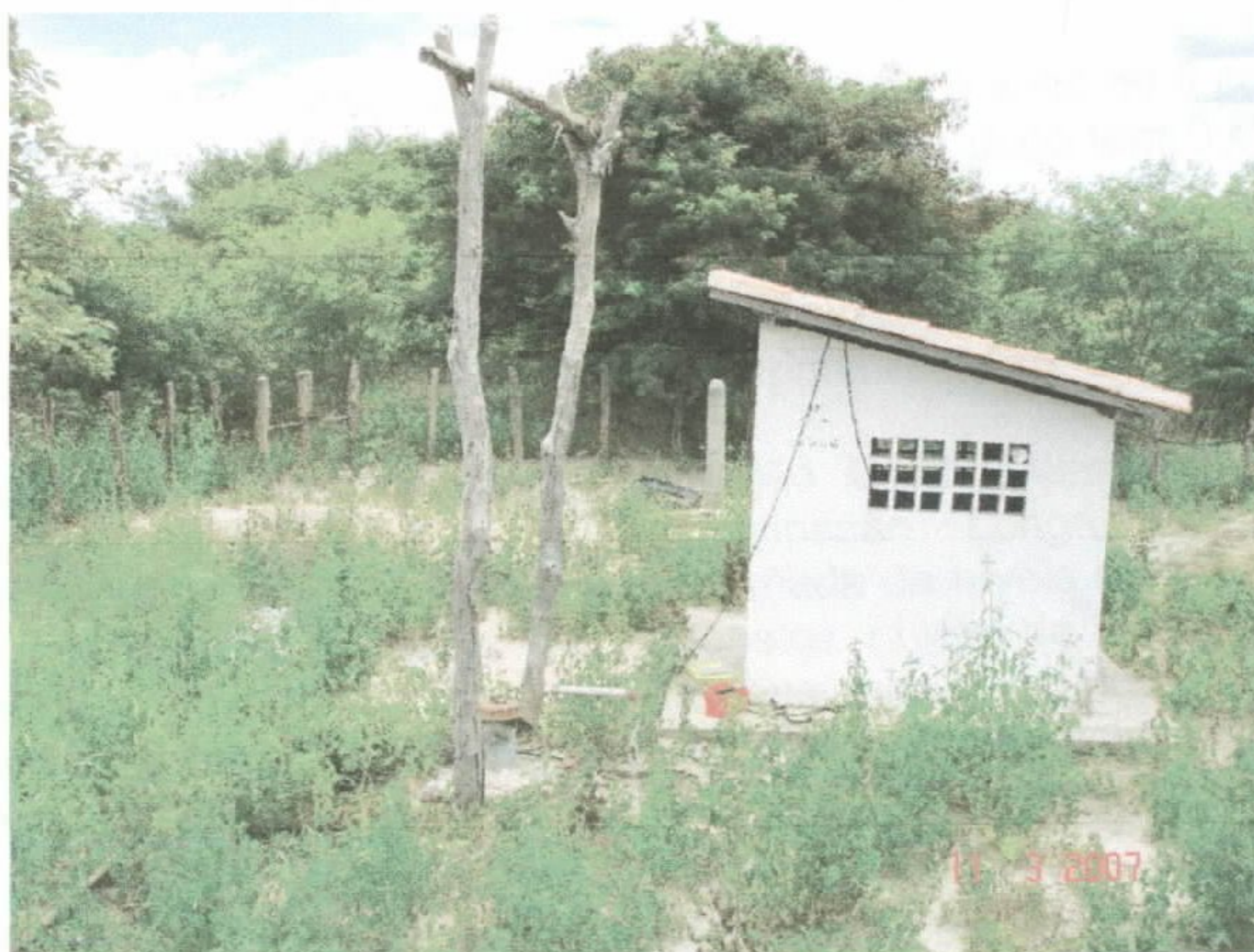
Vista panorâmica da situação de abandono que se encontra o Sistema Simplificado de Captação e Distribuição. A boca do tubo de revestimento está com a luva encostada e sem rosca, vedando parcialmente.
