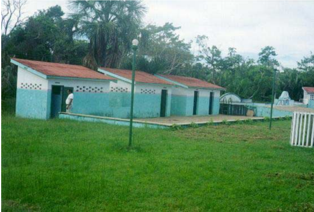
Foto 43 - Aspecto da infra-estrutura existente nas fontes termais sulfurosas do Menino Deus, constando de banheiros.
