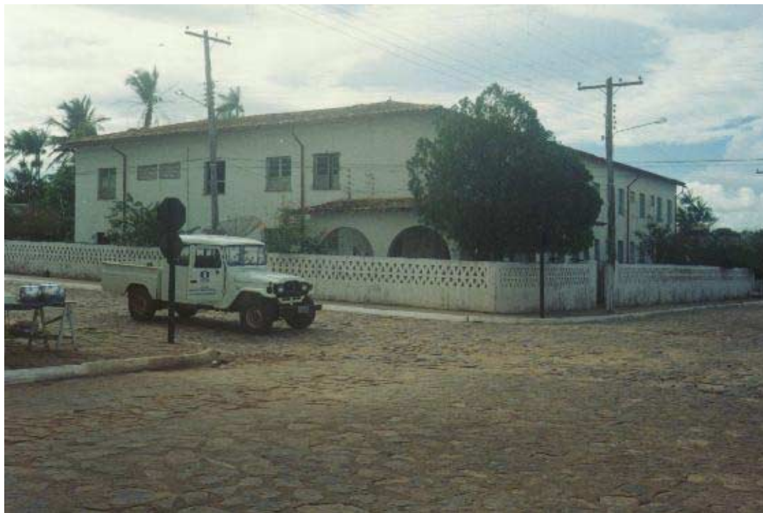
Foto 3 – Hotel Casa de Férias, localizado no bairro da Cidade Alta.
