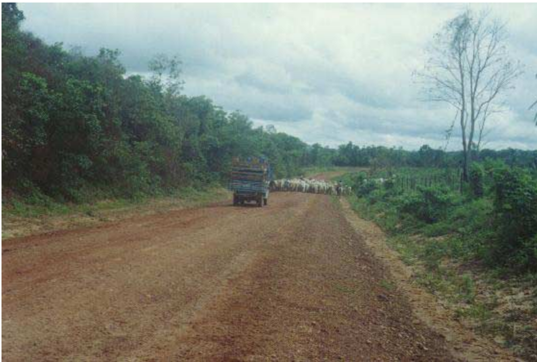
Foto 1 – Rodovia PA-423 mesmo não sendo pavimentada, a rodovia apresenta razoáveis condições de tráfego, durante o ano inteiro.
