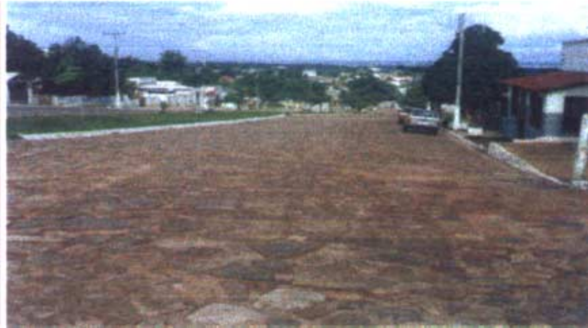
Foto 3 – Rua da cidade de Monte Alegre, pavimentada com material proveniente da Formação Ererê.
