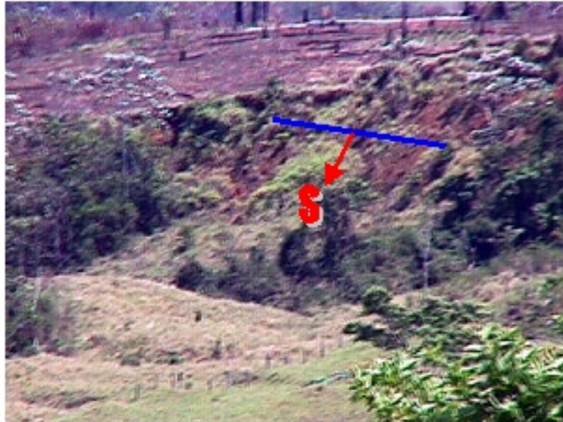
Foto 13: Idem anterior, com detalhamento ainda maior, podendo-se observar o espelho do plano de deslizamento (indicado), interpretado como uma falha recente (neotectônica).
