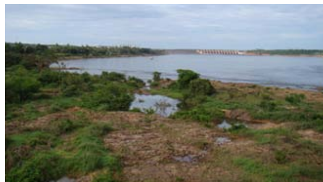
Figura 12.94 - Basalto fraturado às margens do rio Tocantins, utilizado como suporte para fundação da hidrelétrica de Estreito (fundo da figura). Rodovia BR-010, município Estreito (MA).
