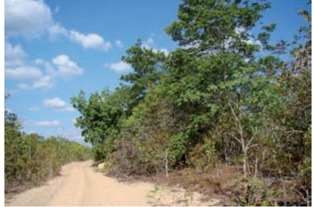
Figura 12.53 - Estrada instalada sobre espessos areões, de difícil trafegabilidade, da unidade geoambiental DSVMPae. Rodovia MA-132, município Fernando Falcão (MA).
