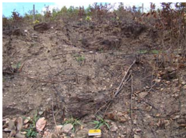
Figura 12.105 - Metarenitos intemperizados, com feições de deslocamento e bloco soltos. Rodovia MA-306, município Centro Novo do Maranhão (MA).
