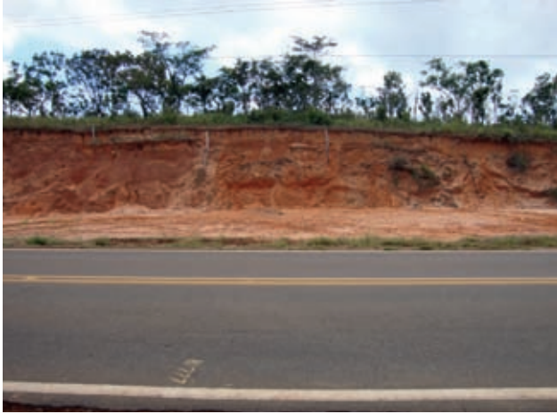
Figura 5.2 - Afloramento do aquífero Sambaíba, em corte na rodovia BR-230, representado por arenito avermelhado, fino a médio, muito friável. Município de Carolina (MA).
