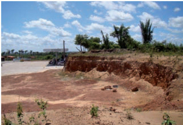
Figura 12.36 - Talude de corte em material com perfil laterítico profundo, com predomínio de crosta laterítica, com alto potencial para extração de saibro para uso na construção civil. Rodovia MA-402, município Morros (MA).
