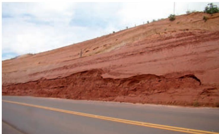
Figura 3.30 - Taludes íngremes e aterros de estrada sobre mantos de alteração com alta suscetibilidade à erosão dos arenitos estratificados da formação Itapecuru em relevo de morros dissecados francamente entalhado por rede de canais de alta densidade de drenagem. Rodovia BR-222, entre as localidades de Santa Luzia e Buriticupu.
