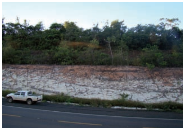
Figura 12.76 - Talude de corte em perfil laterítico, rico em material caulínico, coerente, pouco permeável e moderadamente fraturado, sobreposto por Latossolo e vegetação arbórea. Rodovia BR-226, município Barra do Corda (MA).
