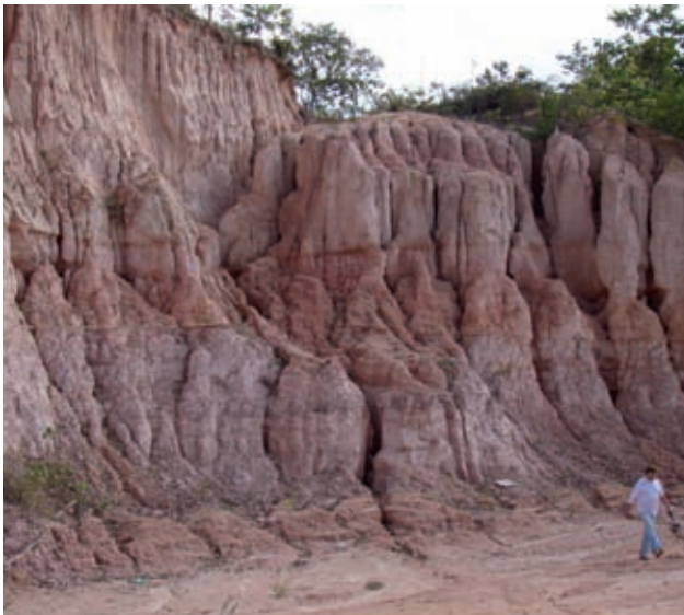
Figura 12.73 - Perfil de rocha alterada composta por intercalação de camadas arenosas com lâminas de argilitos caulinizados, com alto potencial erosivo induzido e alto potencial para desestabilizações geotécnicas. Rodovia BR-316, município Santa Luzia do Paruá (MA).
