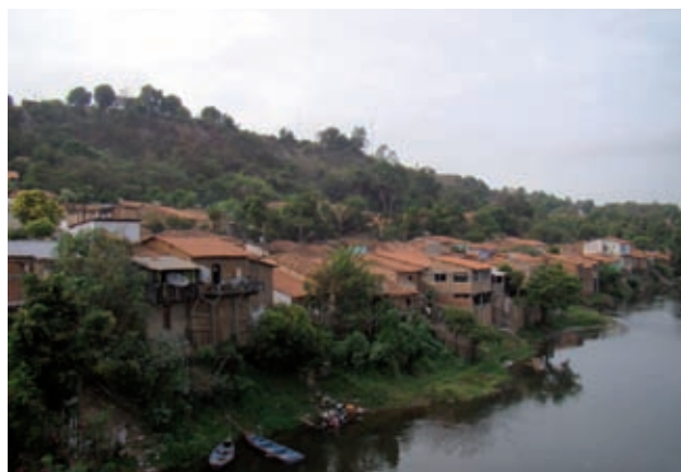
Figura 12.16 - Residências instaladas sobre planície aluvionar, com alto risco de sofrerem inundações, devido ao aumento do nível do rio Mearim. Município Barra do Corda (MA).
