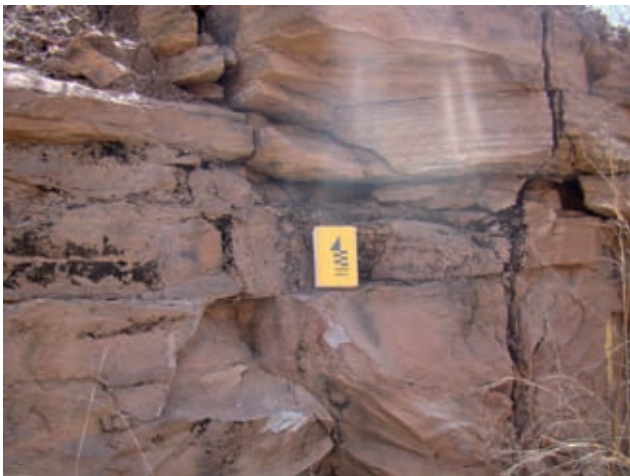
Figura 12.48 - Arenito da unidade geoambiental DSVMpaef, geotecnicamente coeso, com fraturas de alívio e de tensão. Rodovia BR-230, município Barão de Grajaú (MA).
