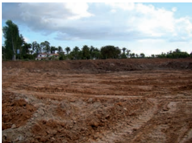
Figura 12.15 - Cava a ser preenchida por água pluvial, com o objetivo de se construir lagos artificiais para piscicultura. Área composta, geotecnicamente, por material muito plástico e pegajoso. Rodovia MA-014, município Viana (MA), próximo aos grandes lagos da baixada maranhense.
