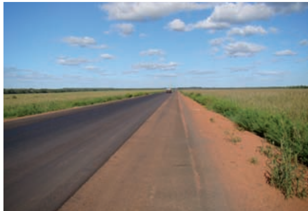
Figura 12.30 - Topo dos baixos platôs, utilizado para implantação de rodovia e plantações de sorgo. Rodovia BR-230, município Riachão (MA).
