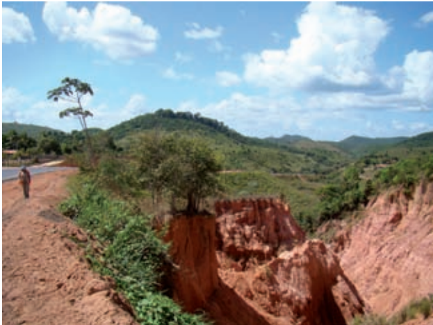
Figura 12.44 - Depósitos sedimentares formados por intercalações de camadas arenoargilosas com siltico-argilosas, com alto potencial erosivo (voçorocas), principalmente quando associados a relevos declivosos, nesse caso, morros e colinas dissecadas. Rodovia BR-222, município Santa Luzia (MA).
