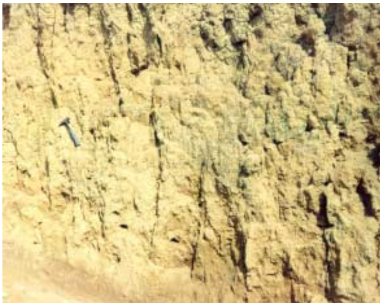
Figura 42 - Depósito coluvial da Aloformação Manso afetado por família de juntas subverticais, de direções NE e NW, na região de Bananal. Corte na estrada de Bananal a Rialto, local BA-01.
