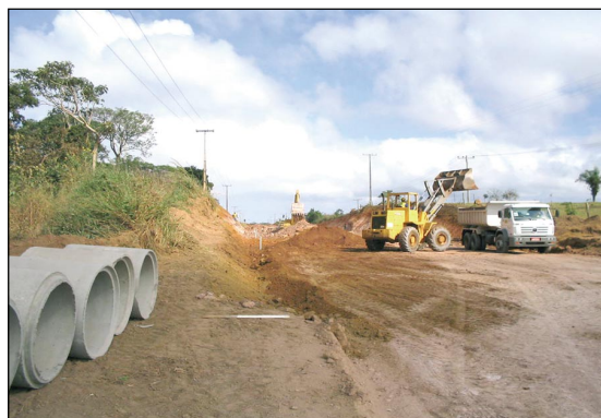
Foto 3.6 – Ponto GR-149. Aspecto do carregamento de cascalho laterítico.
