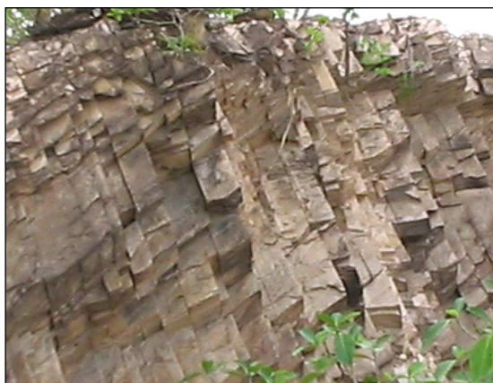
Foto 2.7 – Ponto GS-132. Sistema de fraturas que cortam as rochas da subunidade 6.
