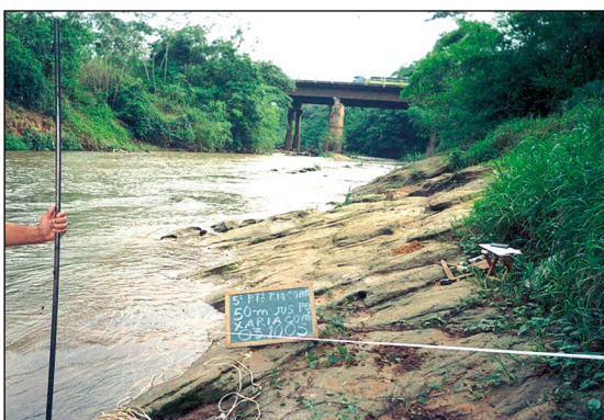
Foto 9.10 – Ponto M20 - Rio Coxipó à jusante da ponte da avenida Fernando Corrêa.
