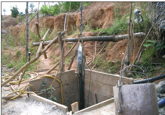
Foto 3.9 – Ponto GR-164. Dimensões do shaft do garimpo de ouro da faz. Santa Edwiges. Observa-se a precariedade do sarilho por onde os garimpeiros descem e o minério é içado.
