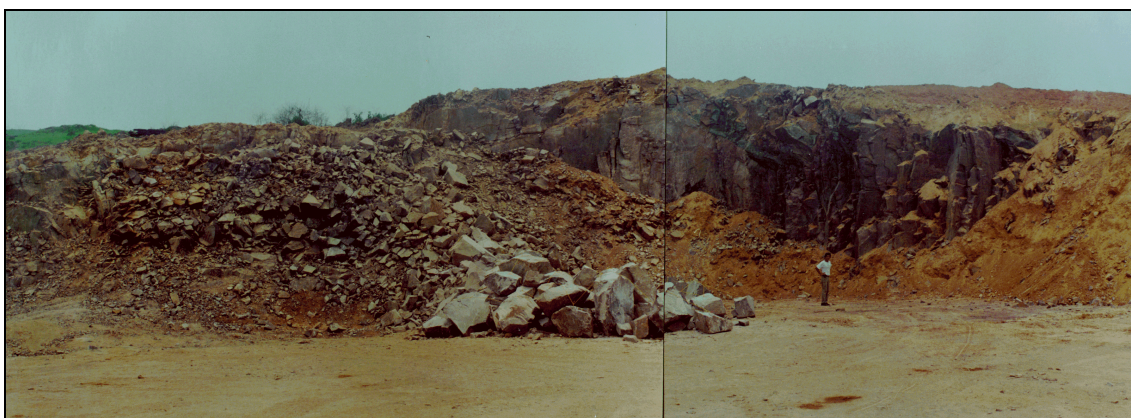
Foto 4.1 – Frente de lavra da “Pedreira do Silvino”, BR-174 no km 150
