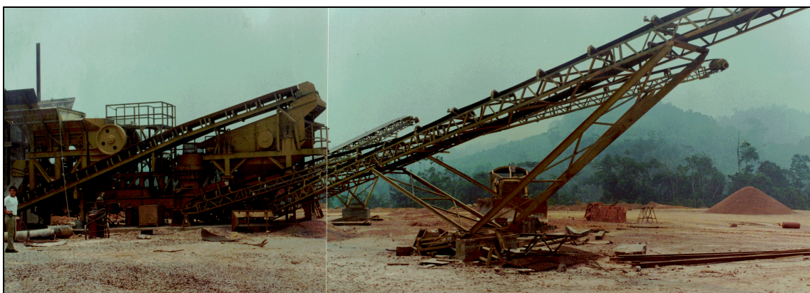
Foto 4.2 – Britador existente na “Pedreira do Silvino”
